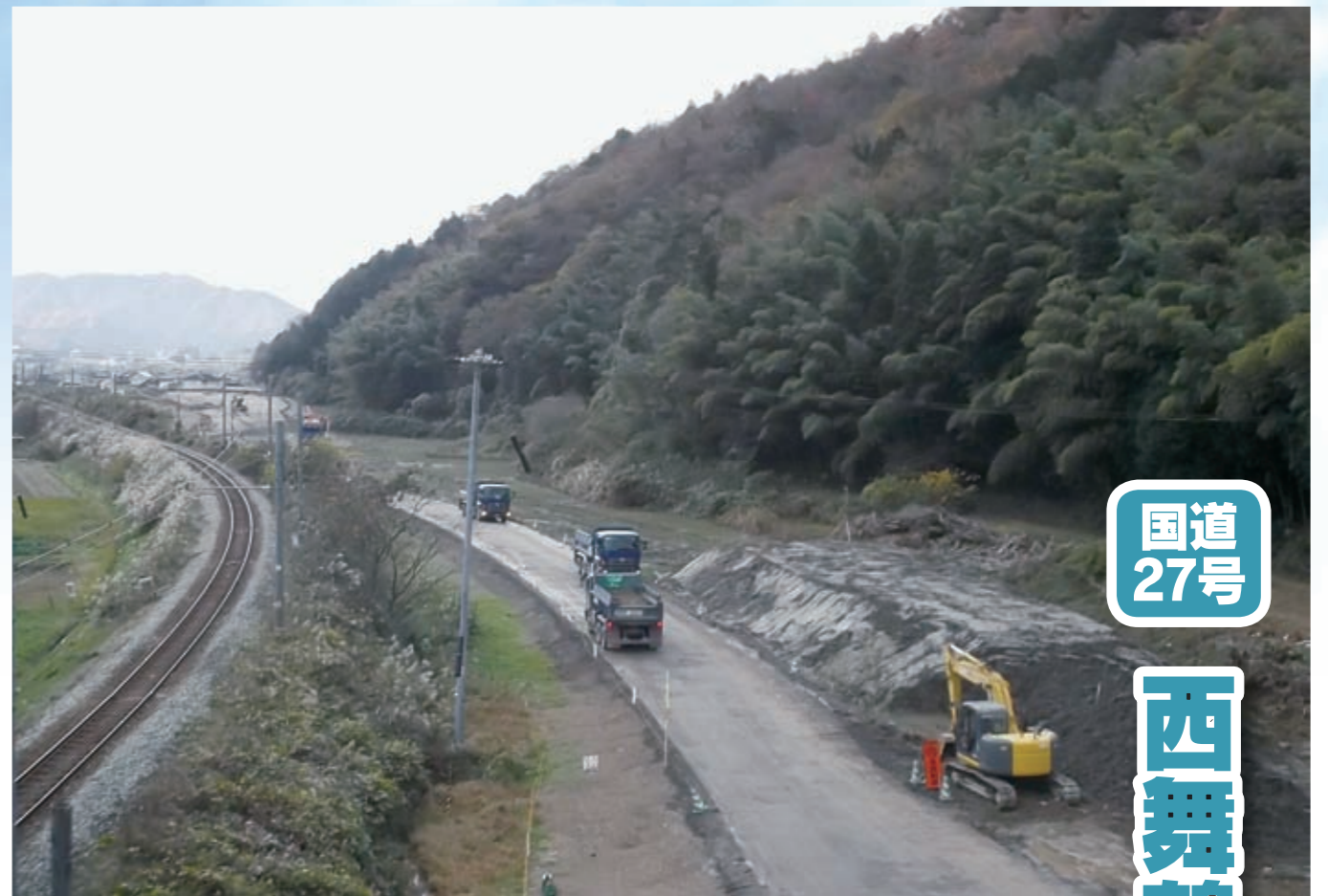
京田地区の一部区間で工事が進む（写真上：南側から撮影。向かって右側を盛り土、中央付近に工事用進入路。写真左：北側から撮影）
