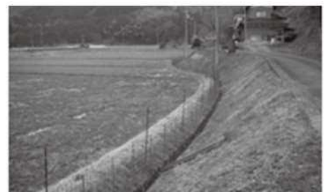
電気柵の設置状況
