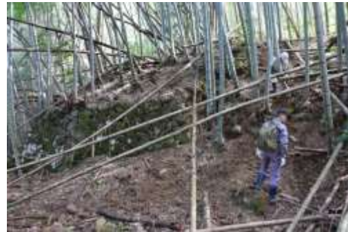
▲北側の崩落の様子(下流側から見る)
