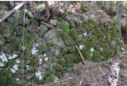
▲敷地北西側の石積み(石垣)、高さは約2m
