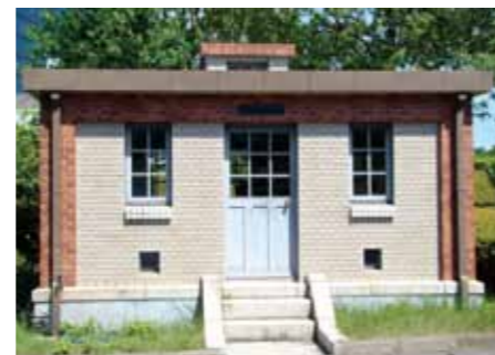
逸見浄水場、ベンチュリーメーター室 (写真提供：横須賀市上下水道局)
