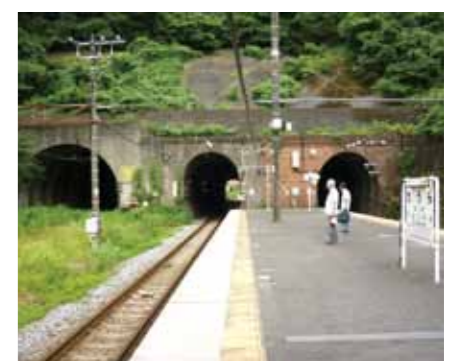
七釜トンネル(横須賀市)
