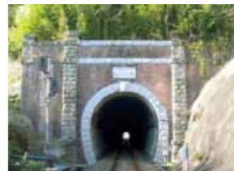
南風崎トンネル
