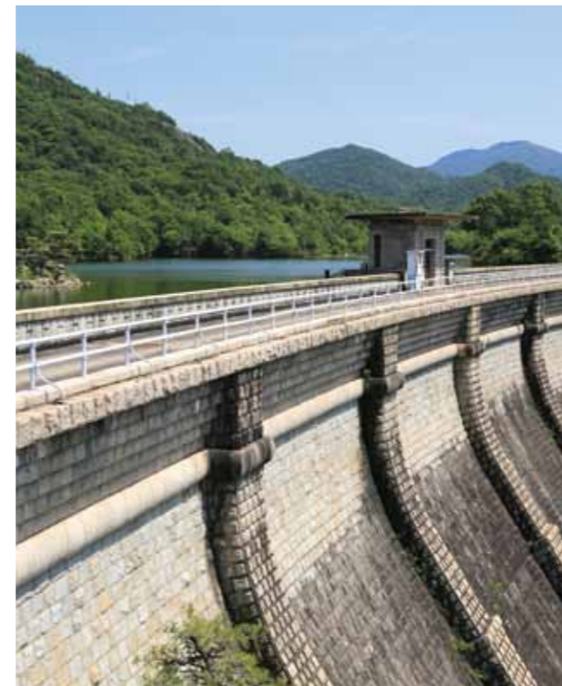
本庄水源堰堤水道施設(呉市)
