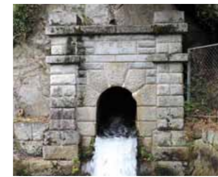
二河水源地取入口(呉市)
