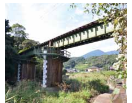
清水の瀬橋梁(佐世保市)
