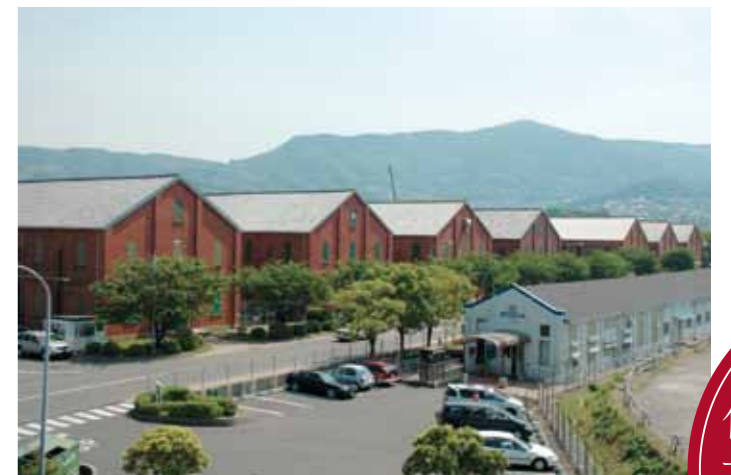
平瀬煉瓦倉庫群
