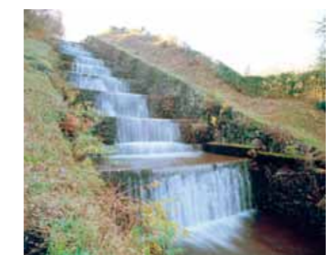
舞鶴市水道施設岸谷貯水池(舞鶴市)
