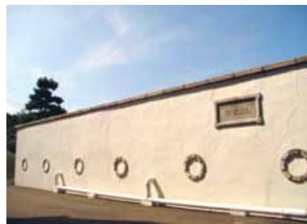
走水水源地、鉄筋コンクリート造浄水池 (写真提供：横須賀市上下水道局)
