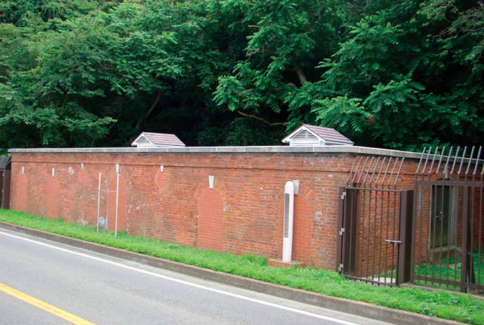
はしりみず 走水水源地 れんが 煉瓦造貯水池 ※国登録有形文化財
