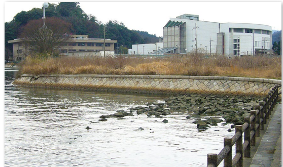
舞鶴旧鎮守府周辺の石積み護岸
