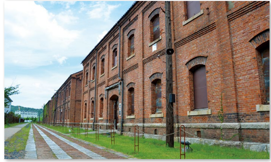
旧舞鶴鎮守府軍需部倉庫
