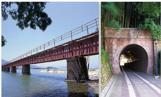
京都丹後鉄道宮舞線施設(左)・北吸トンネル(右)
