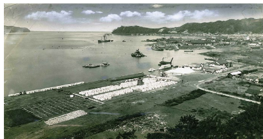
図2-48 西港修築工事
