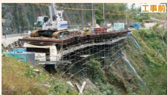
▲急な斜面に鋼管杭を建て込みながら橋の建設工事を進める
