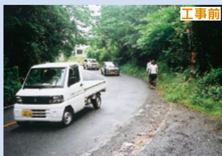
▲カーブがきつく歩道のない工事前の様子
