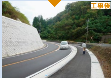
▲カーブと道路勾配を緩め歩道を設置
