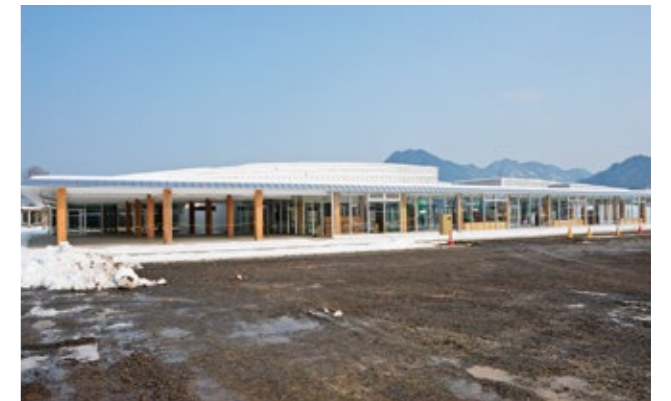
▲建設中の子育て交流施設（2月12日撮影）
