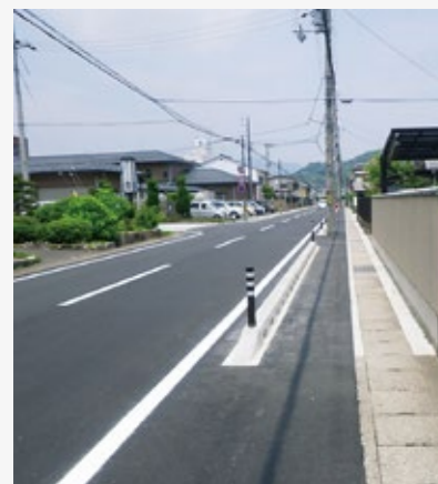
▲高潮対策工事完了後の三の丸通線
