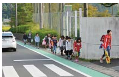
6. 路肩を緑色に着色して歩行スペースを明示 (高野小学校前)
