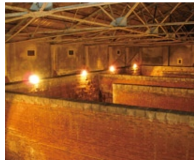
▲旧北吸浄水場施設の第一配水池
