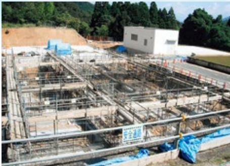
工事中の新管理棟
