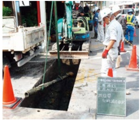
水道管の布設替工事の様子
