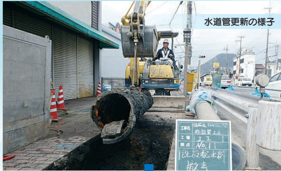
▲老朽化した铸铁管を撤去
