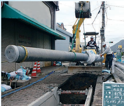
▲ダクタイル铸铁管を布設
