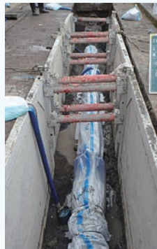
▲更新した水道管
