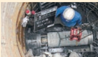
▲最優秀施工者の工事の様子
