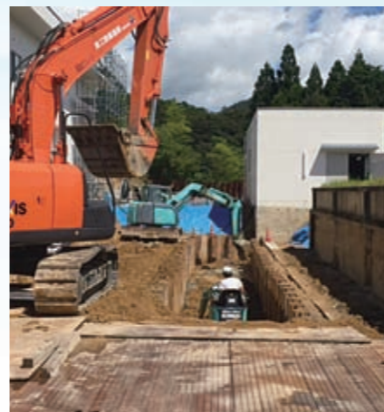
▲上福井浄水場の施設更新
