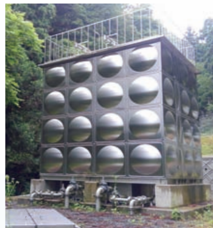
▲岸谷配水池(西地区(池内)簡易水道統合整備事業)
