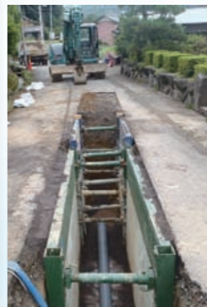
▲下水道管の布設
