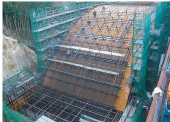
▲真倉トンネルと黒谷トンネルとの間に架かる真倉橋を施工している様子
