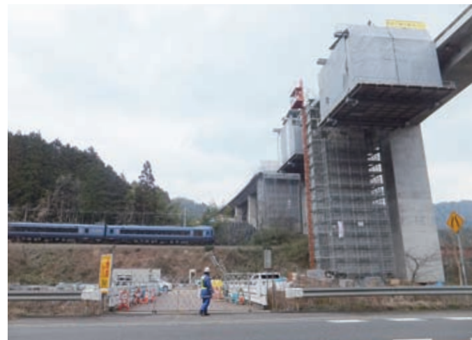
▲伊佐津川橋を施工している様子（綾部市）
