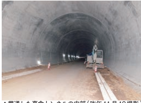
▲貫通した真倉トンネルの内部（昨年11月18撮影）
