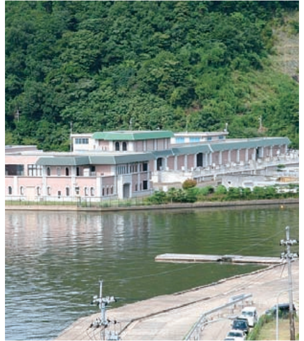
▲東浄化センター (公共下水道事業・東処理区)
