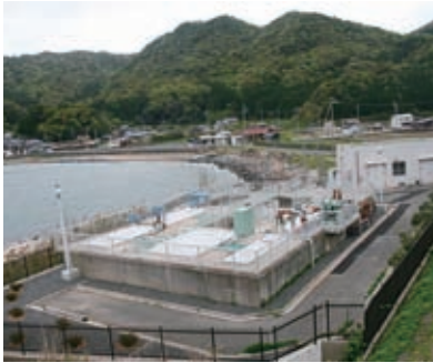
▲野原浄化センター (特定環境保全公共下水道)
