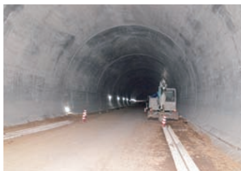
▲貫通した真倉トンネルの内部(昨年11月18撮影)
