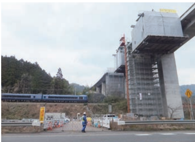
▲伊佐津川橋を施工している様子（綾部市）
