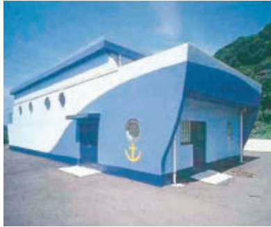
▲田井浄化センター (漁業集落排水事業)
