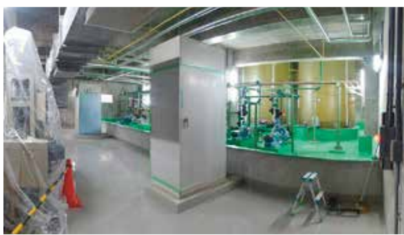
▲管理センター内薬品注入室
