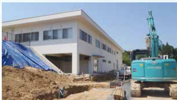
▲施設更新中の上福井浄水場管理センター
