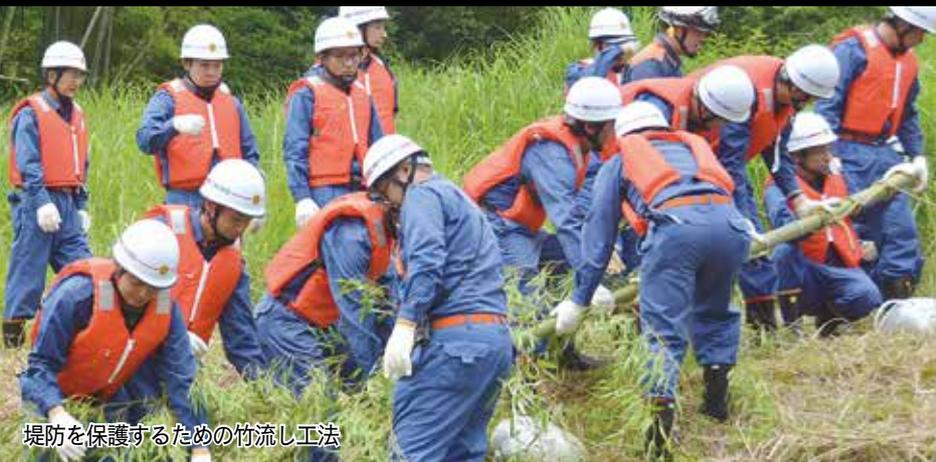
堤防を保護するための竹流し工法
