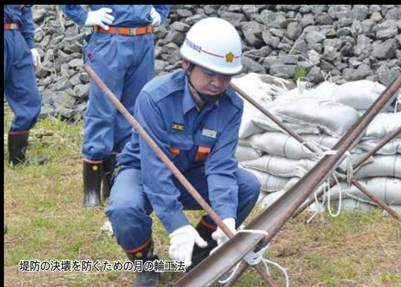
堤防の決壊を防ぐための月の輪工法
