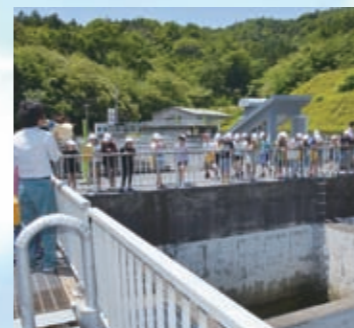
▲上福井浄水場の様子
