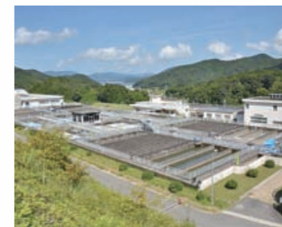
▲上福井浄水場
