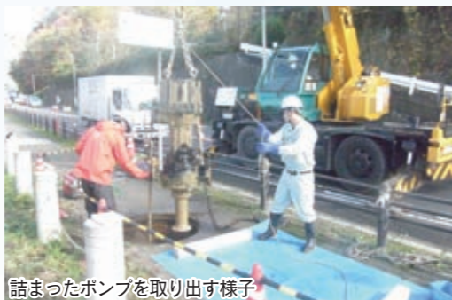
詰まったポンプを取り出す様子
