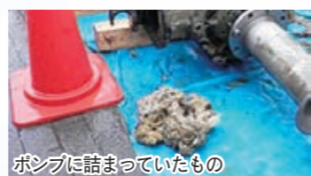
ポンプに詰まっていたもの
