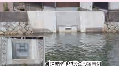
西地区浸水対策事業【2,377万円】 水位監視装置や逆流防止施設を設置、宅地かさ上げ助成など浸水軽減への対策を推進
