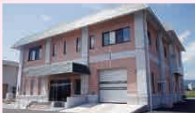
し尿処理施設改築事業【4億9,968万円】 環境衛生プラントの建設(平成29年8月竣工、総事業費は約12億5,000万円)
