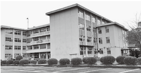
大規模改修となる城南中学校
