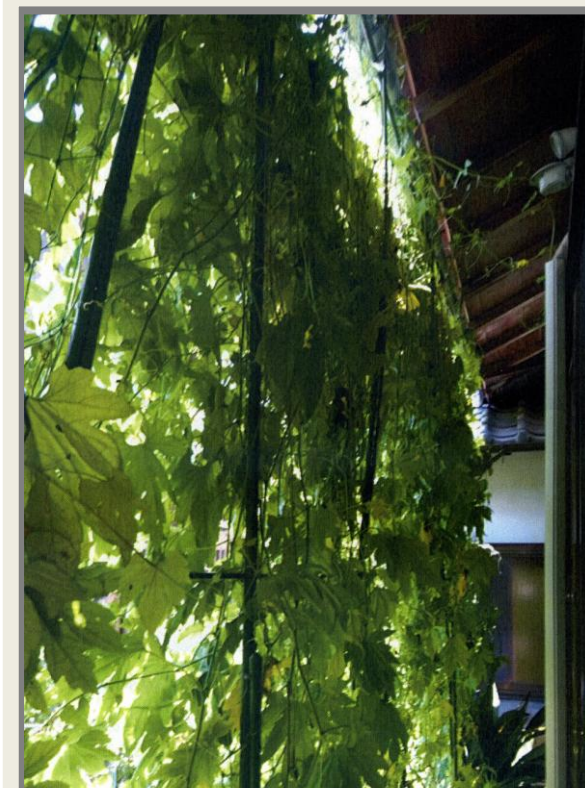
午後 1 時、2 部屋の廊下をカーテンが涼しくしてくれている。部屋から撮影。
