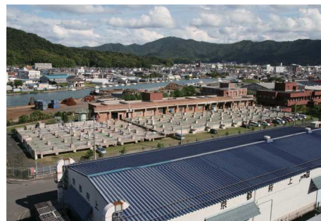
西浄化センター
