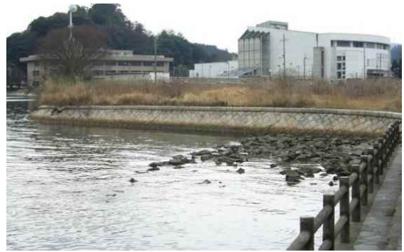
舞鶴旧鎮守府周辺の石積み護岸
