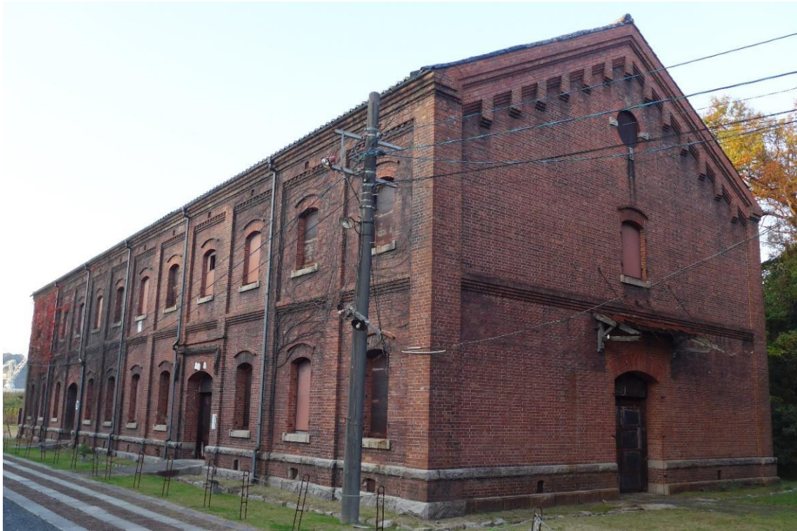
図 1.3.14 8号棟（需品庫三棟のうち西側の棟）（南から撮影）
