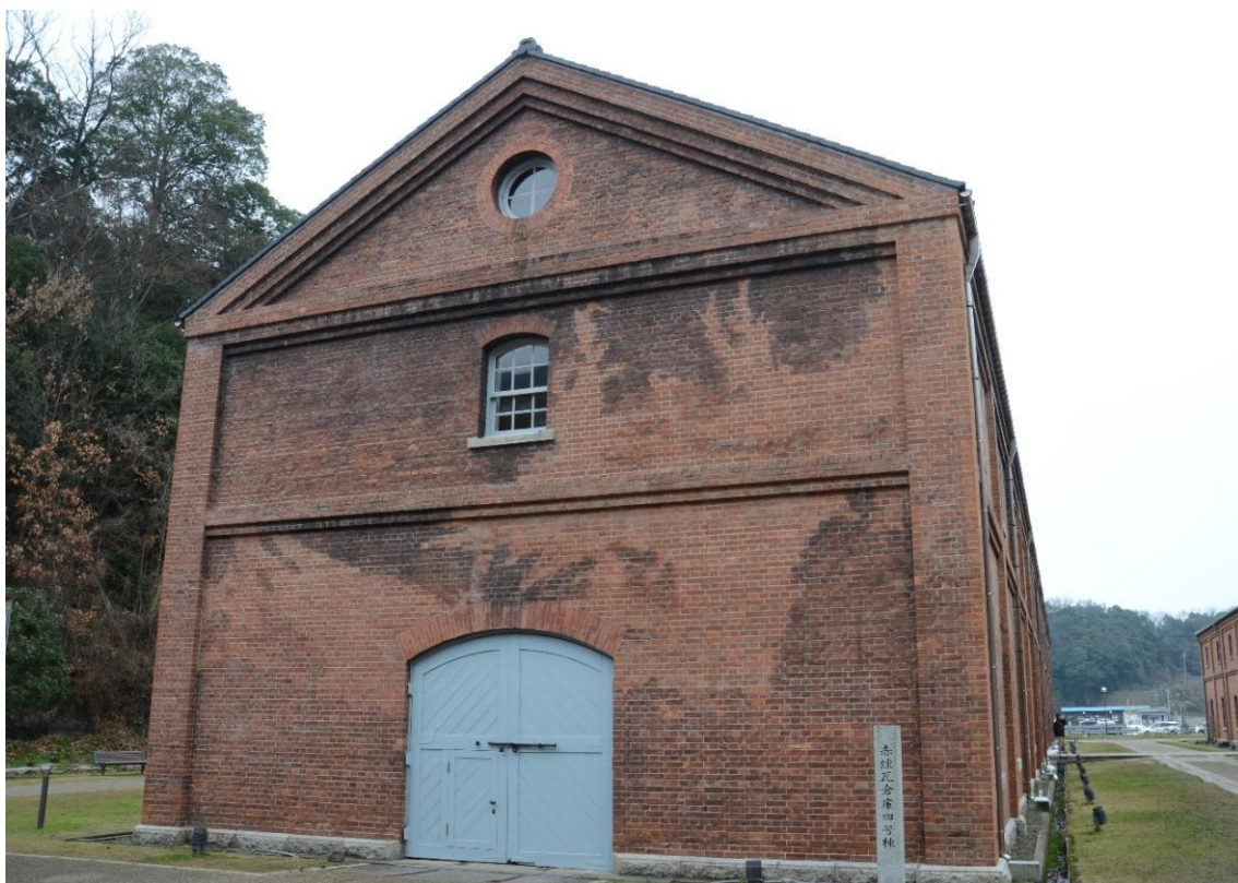
図 1.3.8 4号棟（南から撮影）
