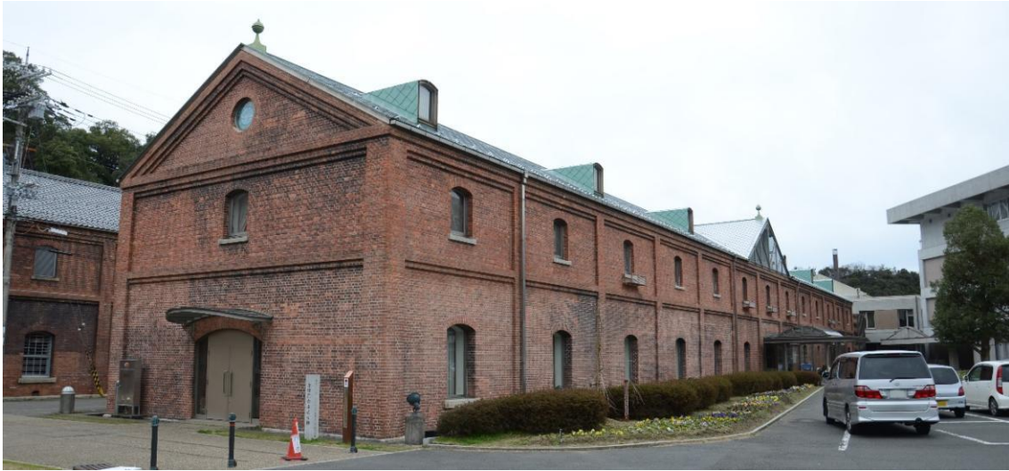
図 1.3.4 2号棟（南東から撮影）
