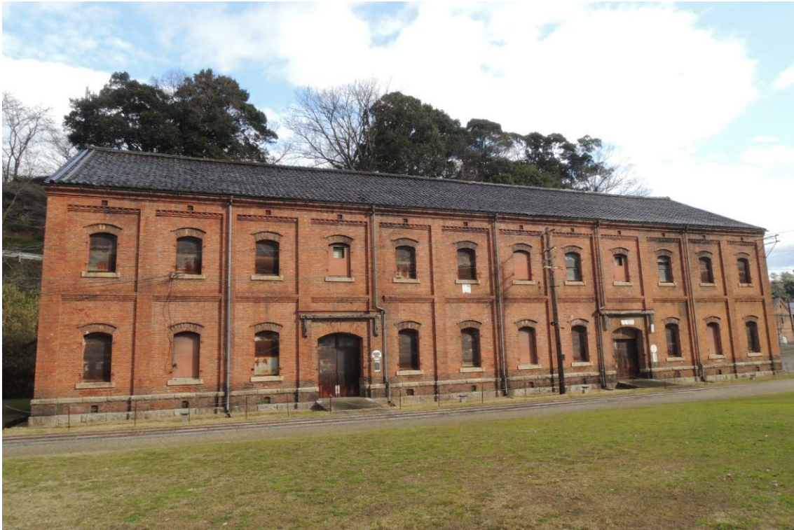
図 1.3.12 6号棟（需品庫三棟のうち東側の棟）（西から撮影）
