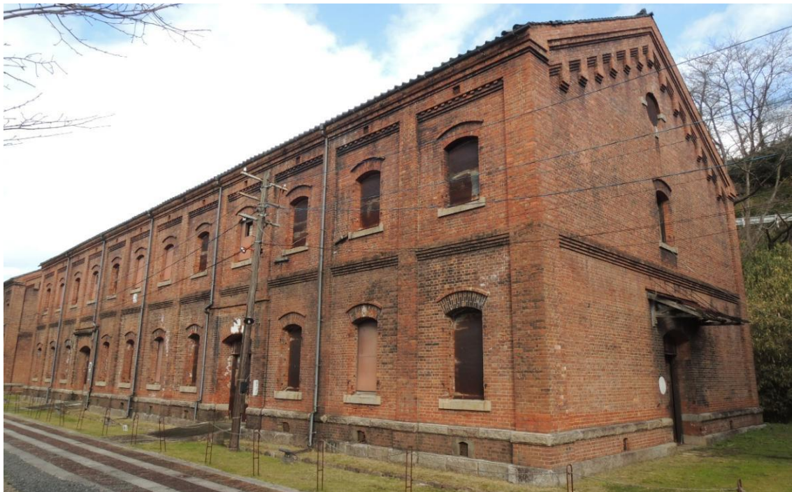
図 1.3.13 7号棟（需品庫三棟のうち中央の棟）（南から撮影）
