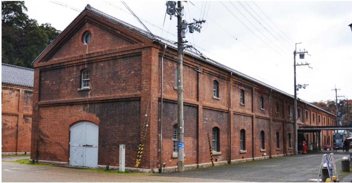
図 1.3.6 3号棟（南東から撮影）
