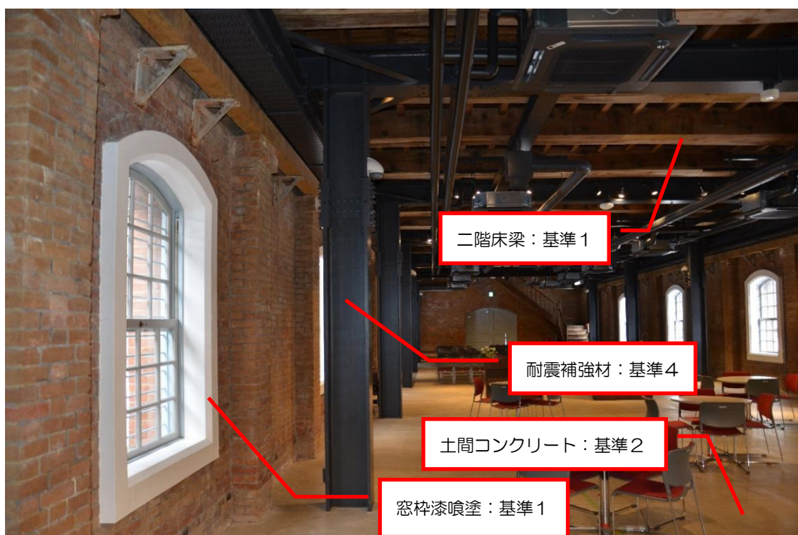
一階 北面を見る
