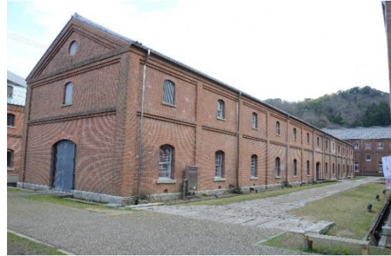
図 2.1.6 3号棟北西面 全景
