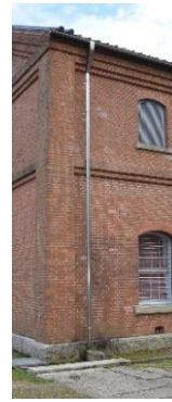
図 2.1.100 雨樋（左3号棟、右4号棟受金具）
