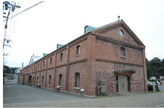
図 2.1.4 2号棟北西面 全景
