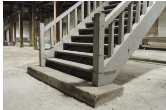
図 2.1.134 7号棟 階段一階部分
