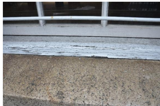
図 2.1.121 塗装の劣化
