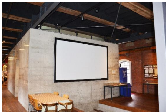
図 2.1.97 3号棟耐震補強
