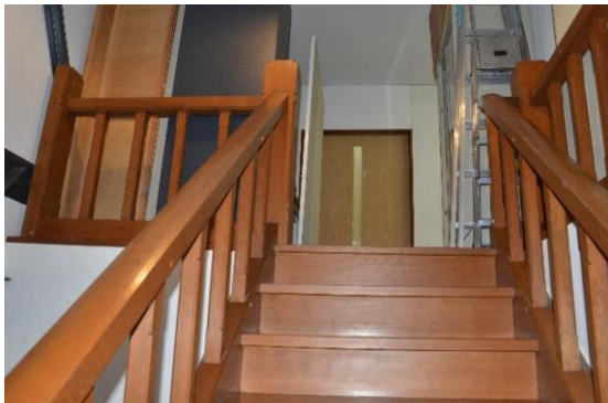
図 2.1.46 木造階段廻り
