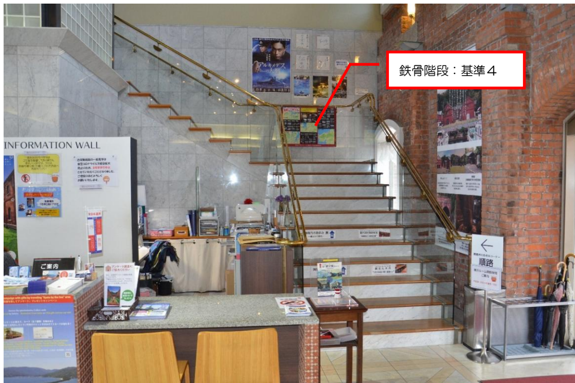
一階中央 鉄骨階段
