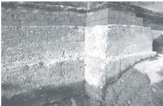
図 2. 1. 101 基礎（修理工事報告書から抜粋）
