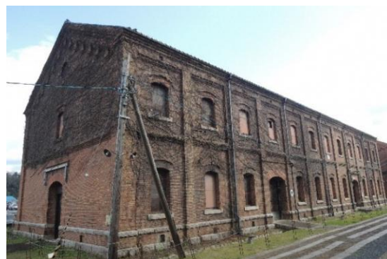
图 2.1.16 8号棟南西面 全景
