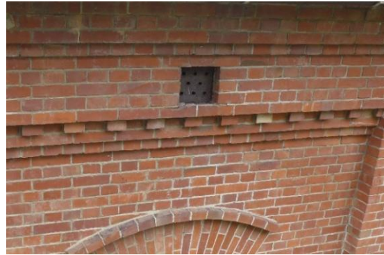
図 2.1.150 8号棟 北面軒下換気口
