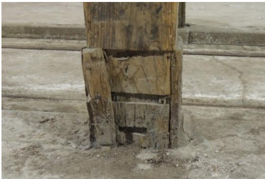
図 2.1.133 6号棟 一階床板痕跡
