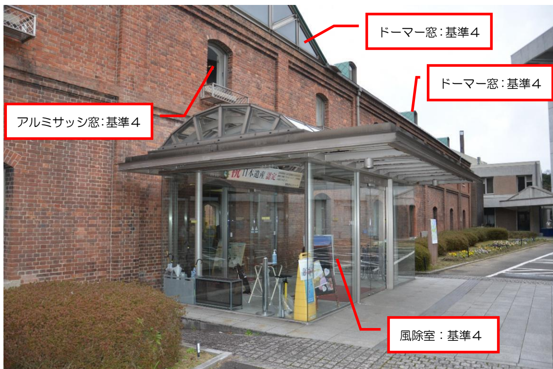
外観 正面（東面）
