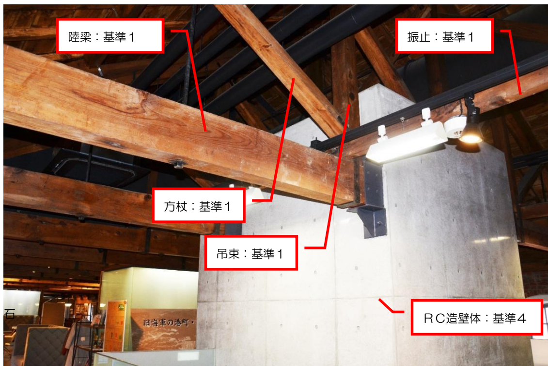
二階 RC造壁体廻り
