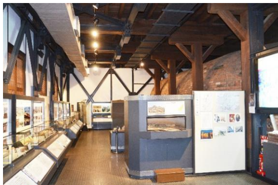
図 2.1.38 一階鉄骨及び木造架構
