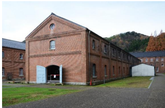
図 2.1.8 4号棟北西面 全景
