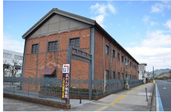
図 2.1.2 1号棟南面・東面 全景
