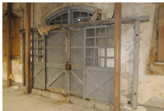
图 2.1.144 6号棟 南面東側出入口
