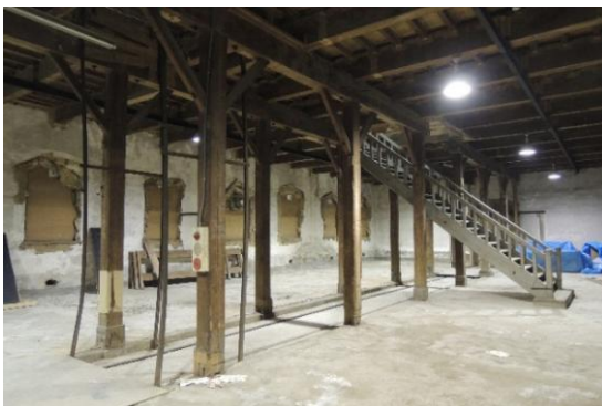
図 2. 1. 129 7号棟 一階 東北を見る
