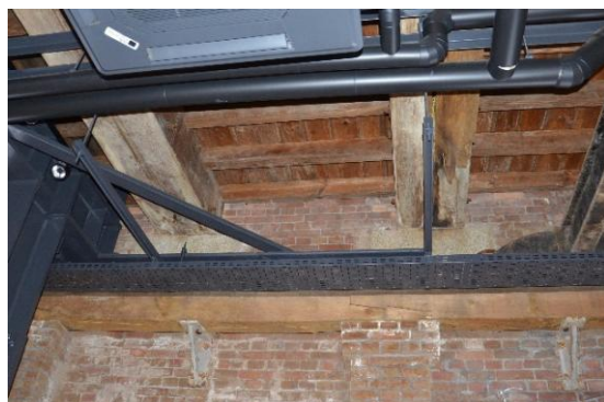
図 2.1.68 4号棟 床梁と壁の取り合い
