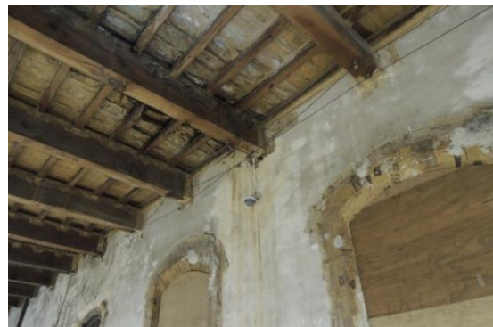
図 2. 1. 130 7号棟 二階梁と壁面の取り合い
