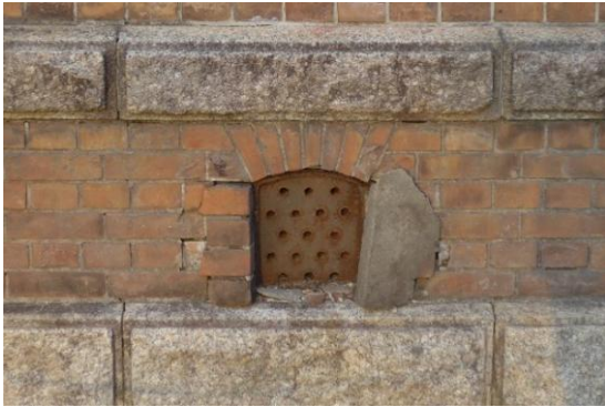
図 2.1.149 6号棟 南面床下換気口
