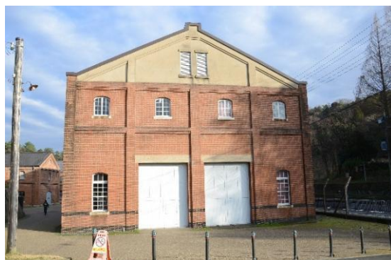
图 2.1.10 5号棟北西面 全景
