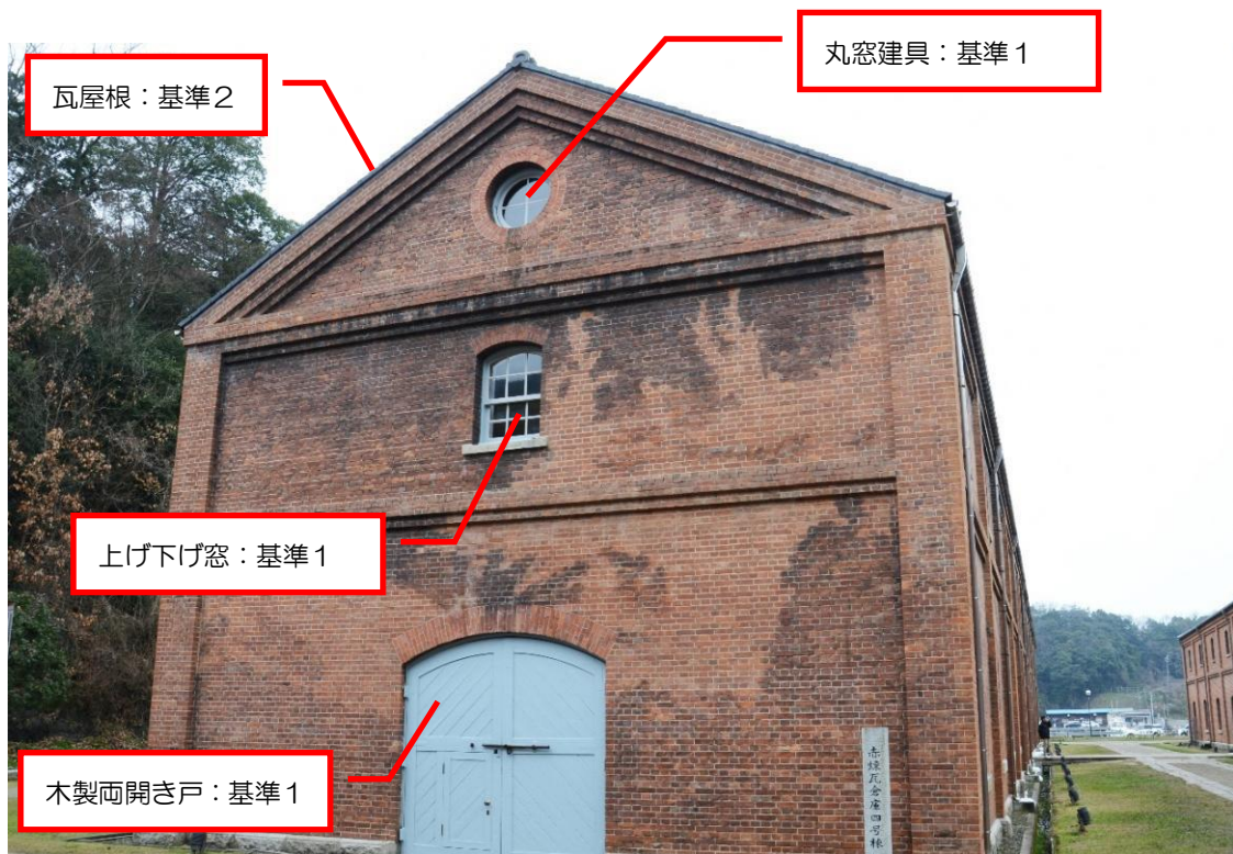
外観 南面・西面
