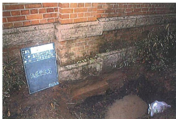
図 2. 1. 124 7号棟基礎周り 試掘調査（平成 17 年実施）
