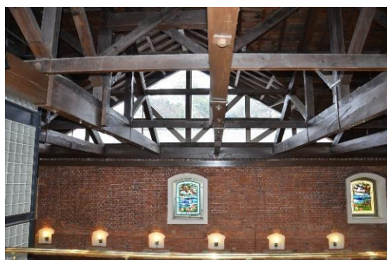
図 2.1.74 2号棟ドーマー窓 西を見る
