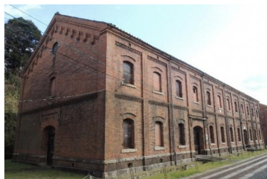
图 2.1.14 7号棟南西面 全景
