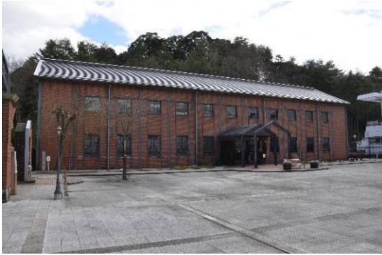
図 2.1.1 1号棟西面（正面） 全景
