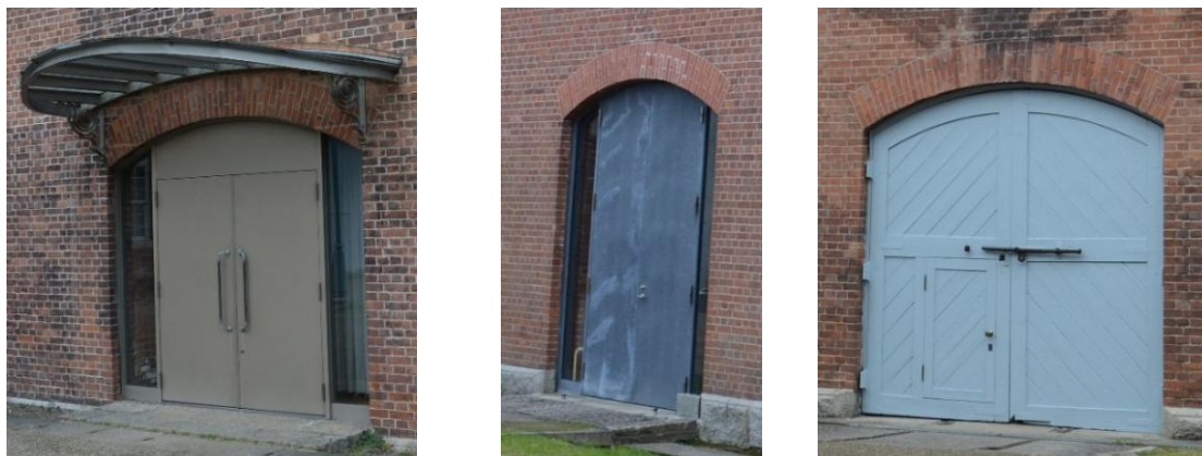
図2.1.91 一階出入口（左から2号棟南面、3号棟北面、4号棟南面）
