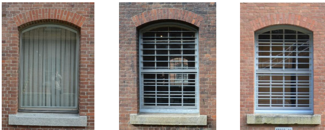
図2.1.92 一階窓（左から2号棟東面、3号棟東面、4号棟西面）
