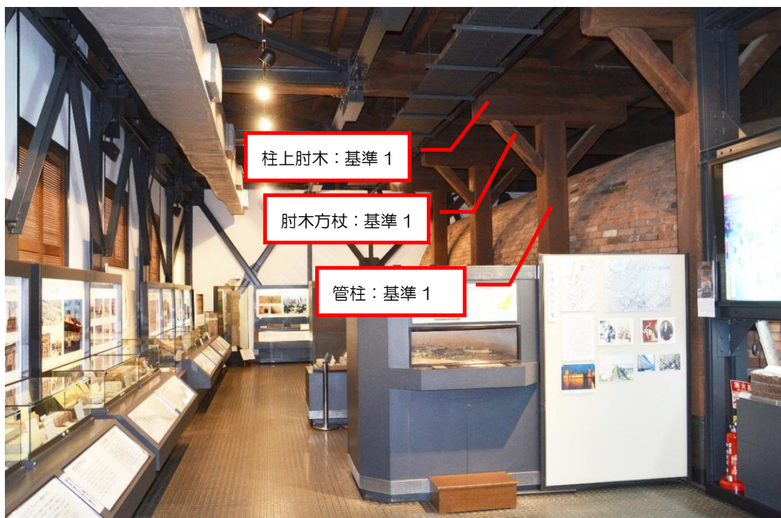
室内 北側を見る
