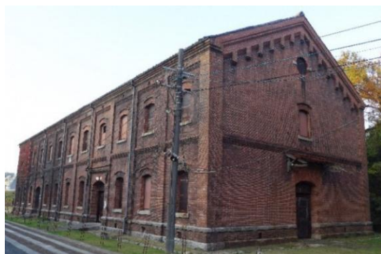
图 2.1.15 8号棟南西面 全景
