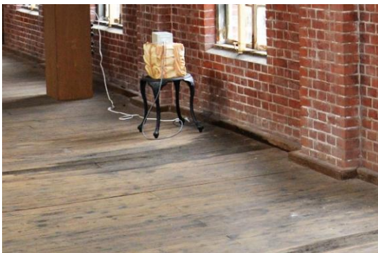
図 2.1.120 二階床雨染み
