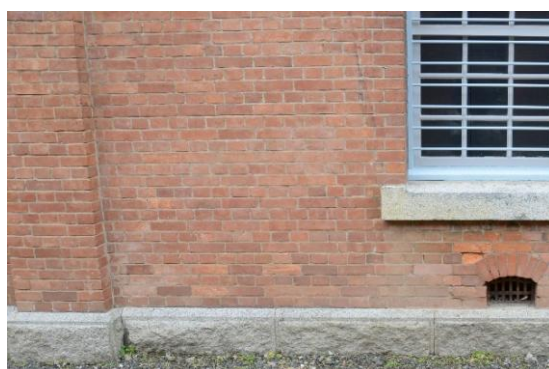
図 2.1.21 参考煉瓦外壁 4号棟イギリス積
