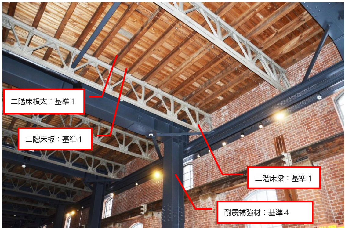
一階天井・二階床梁
