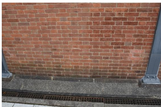
図 2.1.20 煉瓦外壁 1号棟フランス積
