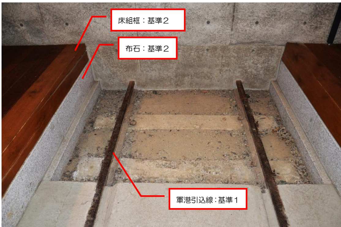
室内レール復旧部分
