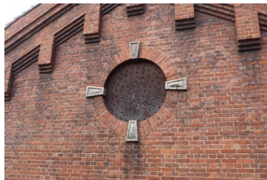
图 2.1.148 7号棟 東面円窓
