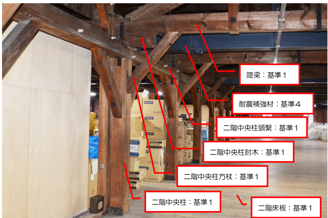
二階 中央柱廻り
