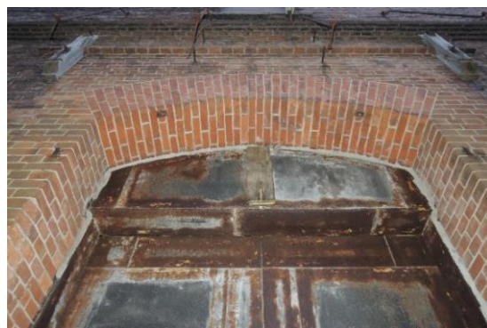
图 2.1.146 7号棟 西面出入口見上げ
