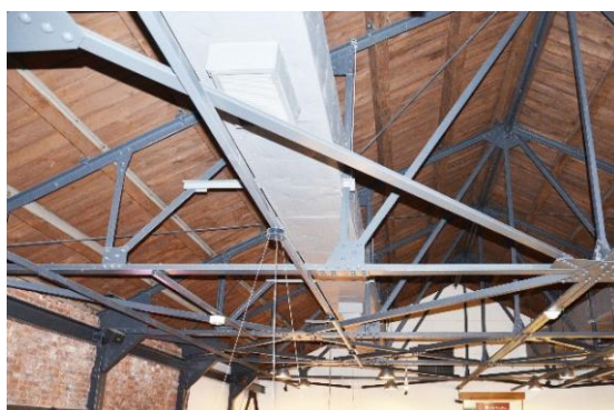
図 2.1.40 小屋組鉄骨トラス
