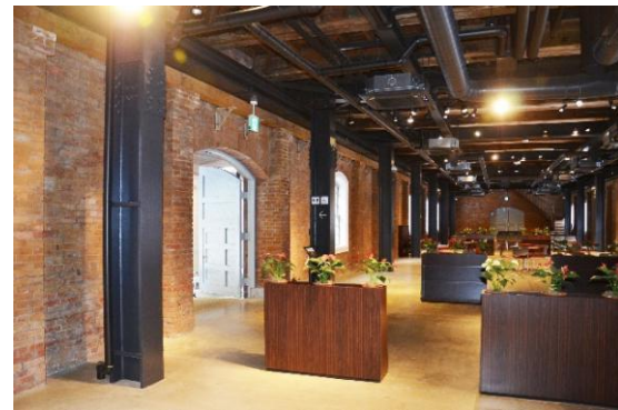
図 2.1.98 4号棟耐震補強
