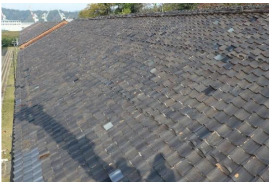
図 2.1.137 6号棟 屋根南流れ
