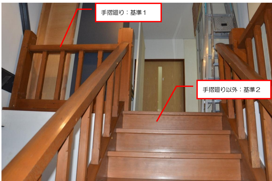
南東階段廻り
