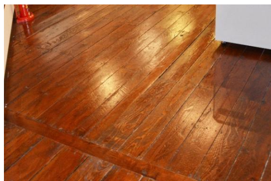
図 2.1.43 二階床 旧荷揚口付近
