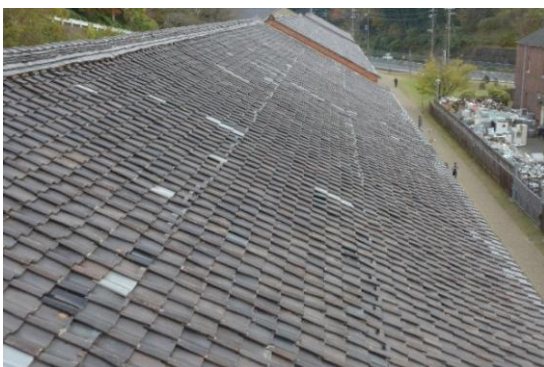
図 2.1.139 8号棟 屋根南流れ
