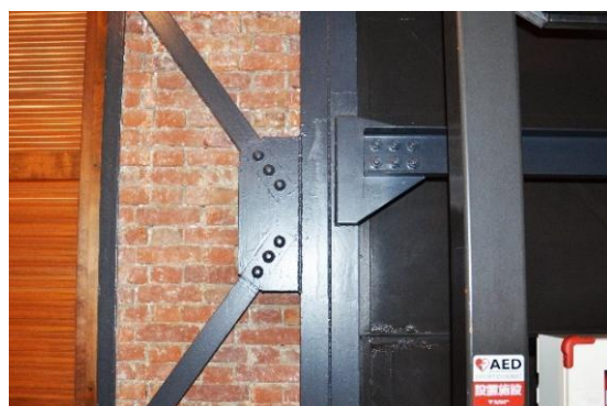
図 2.1.41 当初鉄骨材と補強材の接合部
