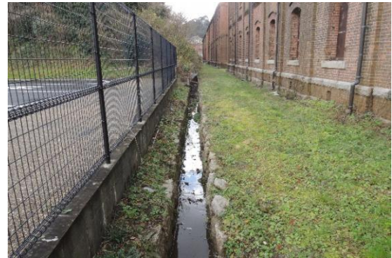
図 3.1.37 敷地内排水路（建物背面側）
