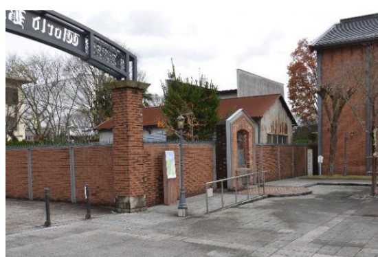
図 3.1.5 区域A北側RC塀・門
