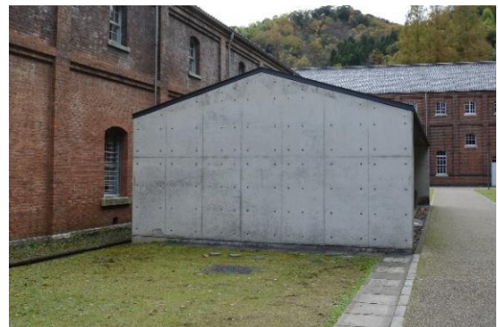
図 3.1.26 4号棟北側トイレ棟
