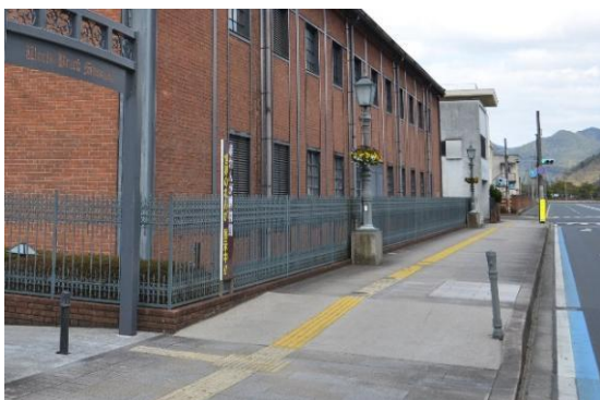
図 3.1.4 区域A東側アルミ鋳物フェンス
