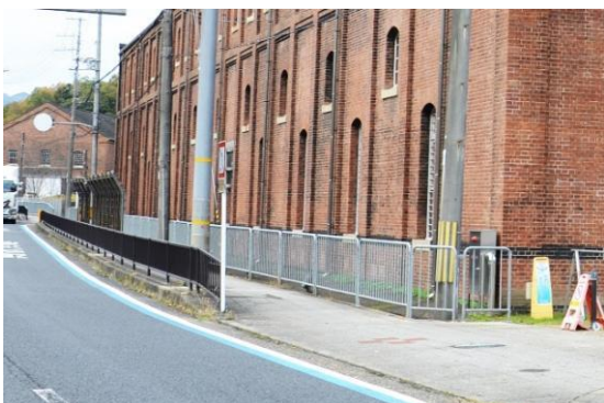
図 3.1.21 区域B 南側 スチールフェンス （国道施設）
