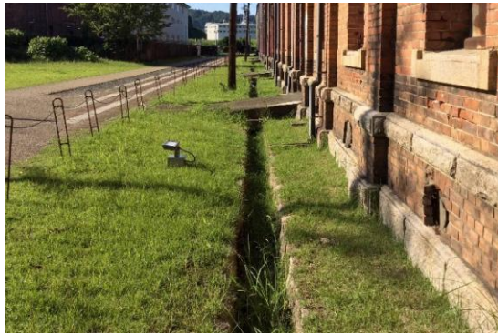
図 3.1.36 敷地内排水路（建物正面側）
