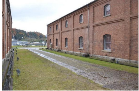
図 3.1.24 3号棟と4号棟の間 石敷通路
