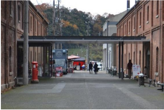
図 3.1.23 2号棟と3号棟の間
