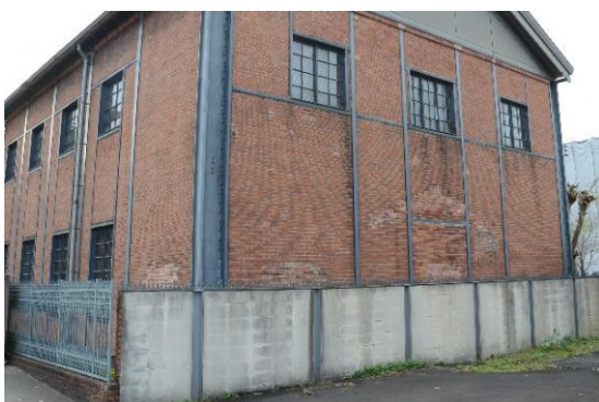
図 3.1.6 区域A北側RC塀 外側
