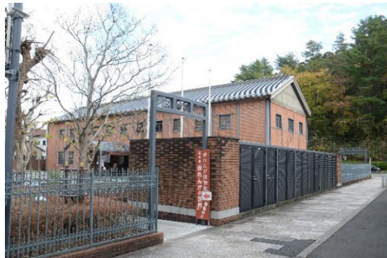
図 3.1.3 区域A南側RC塀・機械置場
