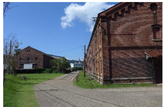
図 3.1.41 アスファルト舗装・電柱等
