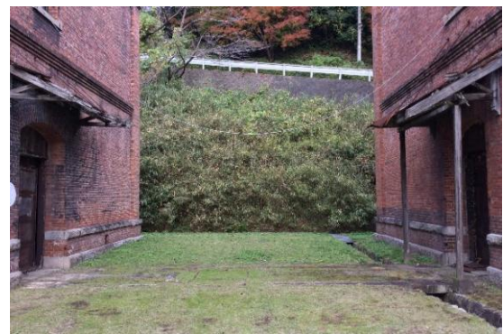
図 3.1.39 6号棟-7号棟間（軍港引込線ほか）
