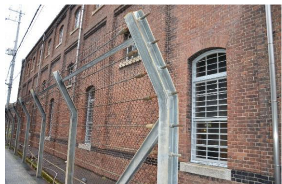
図 3.1.22 区域B 南側 メッシュフェンス （国道施設）
