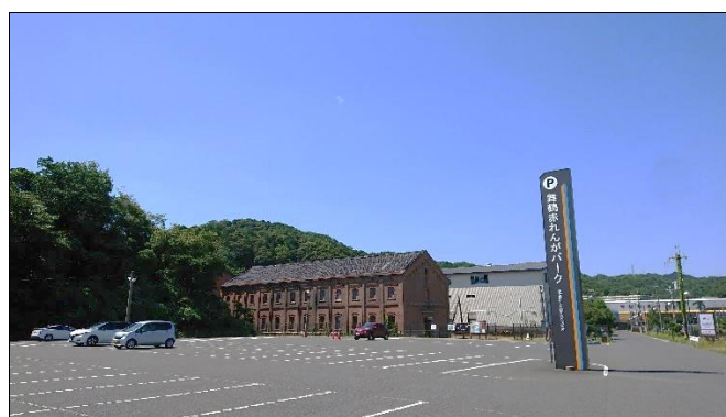
駐車場から見た8号棟
