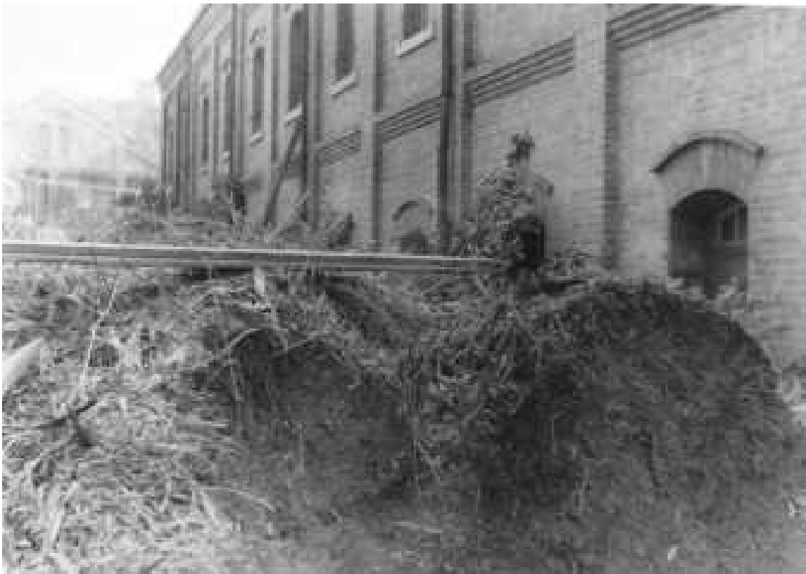
25 昭和28年13号台風被災状況 6号棟北から見る
