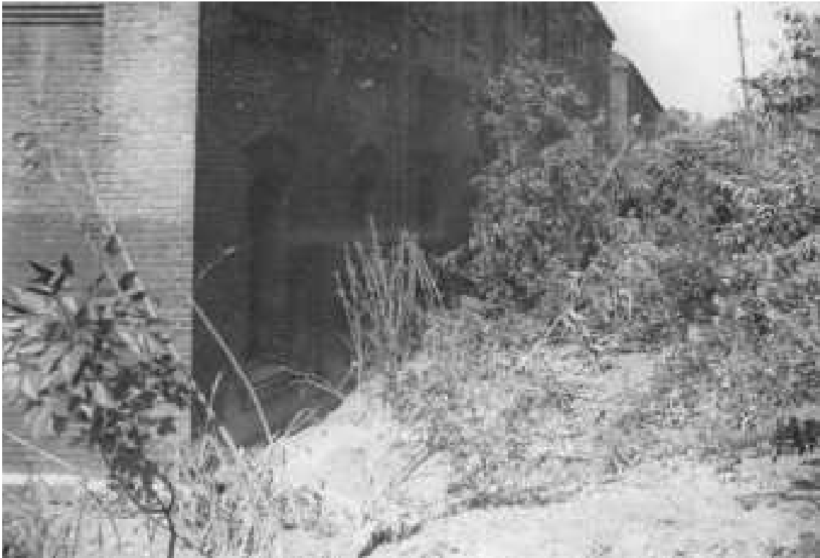
24 昭和28年13号台風被災状況 6号棟南東から見る
