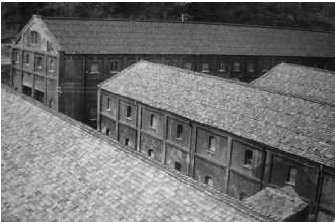
6 3号棟を東から望む（手前屋根は2号棟）
