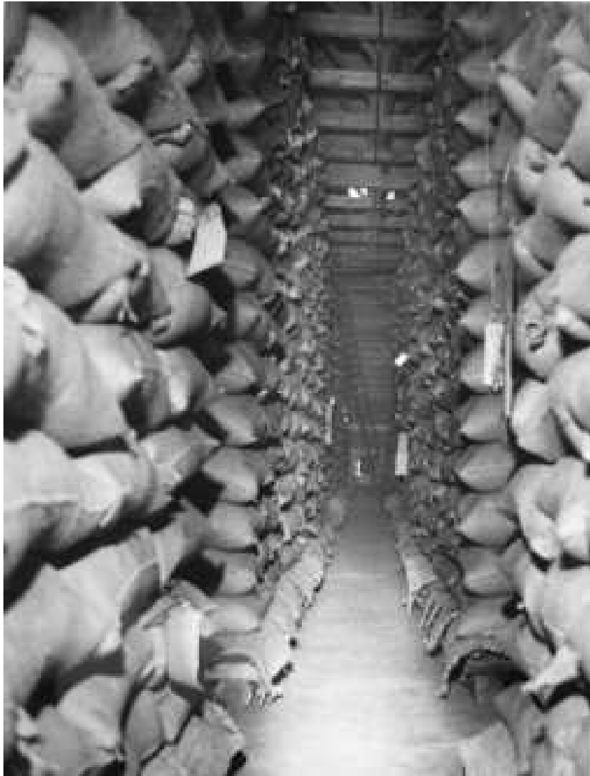
28 倉庫内部（建物不明）
