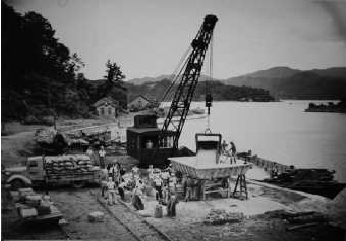
29 3号棟北側岸壁付近
