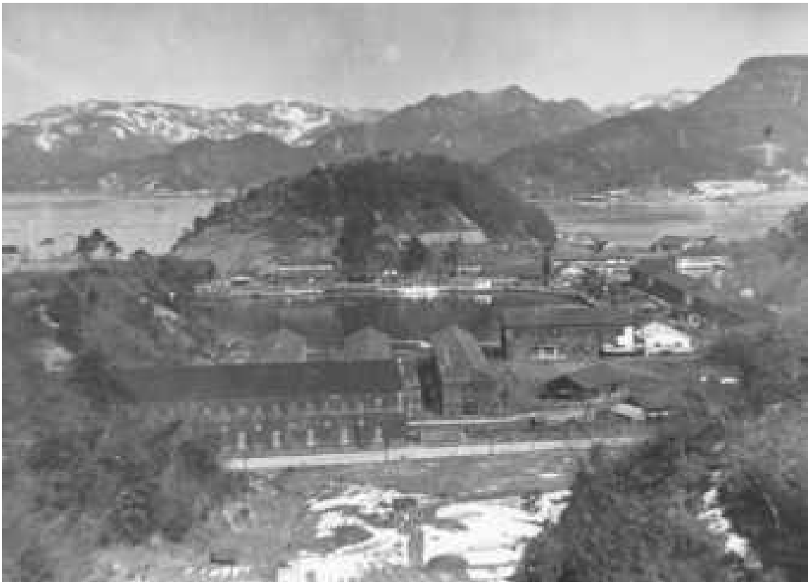
10 倉庫群遠景 南から望む（手前が5号棟）
