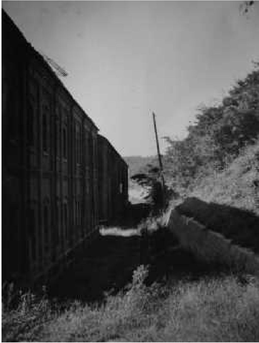
26 昭和28年13号台風被災状況 6号棟南東から見る
