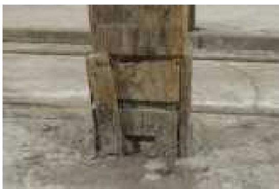
図 2.1.133 6号棟 一階床板痕跡
