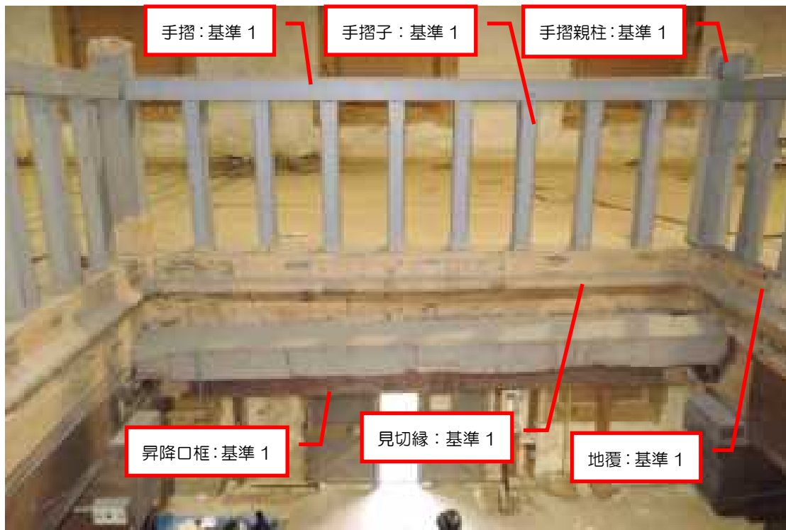
2階 昇降口廻り
