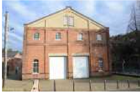
图 2.1.10 5号棟北西面 全景
