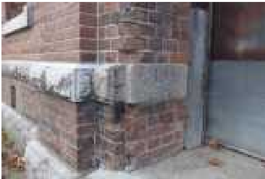
図 2.1.125 8号棟南面出入口 煉瓦破損状況
