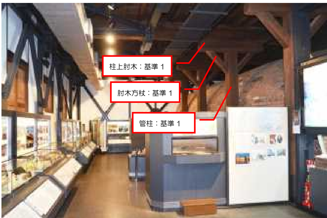
室内 北側を見る
