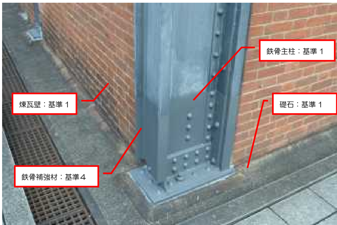
鉄骨主柱 脚部
