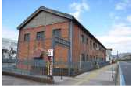
图 2.1.2 1号棟南面・東面 全景
