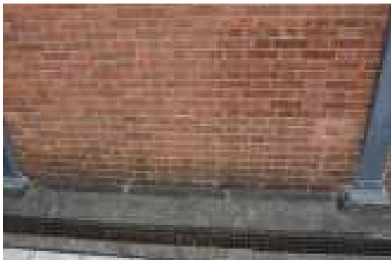
図 2.1.20 煉瓦外壁 1号棟フランス積
