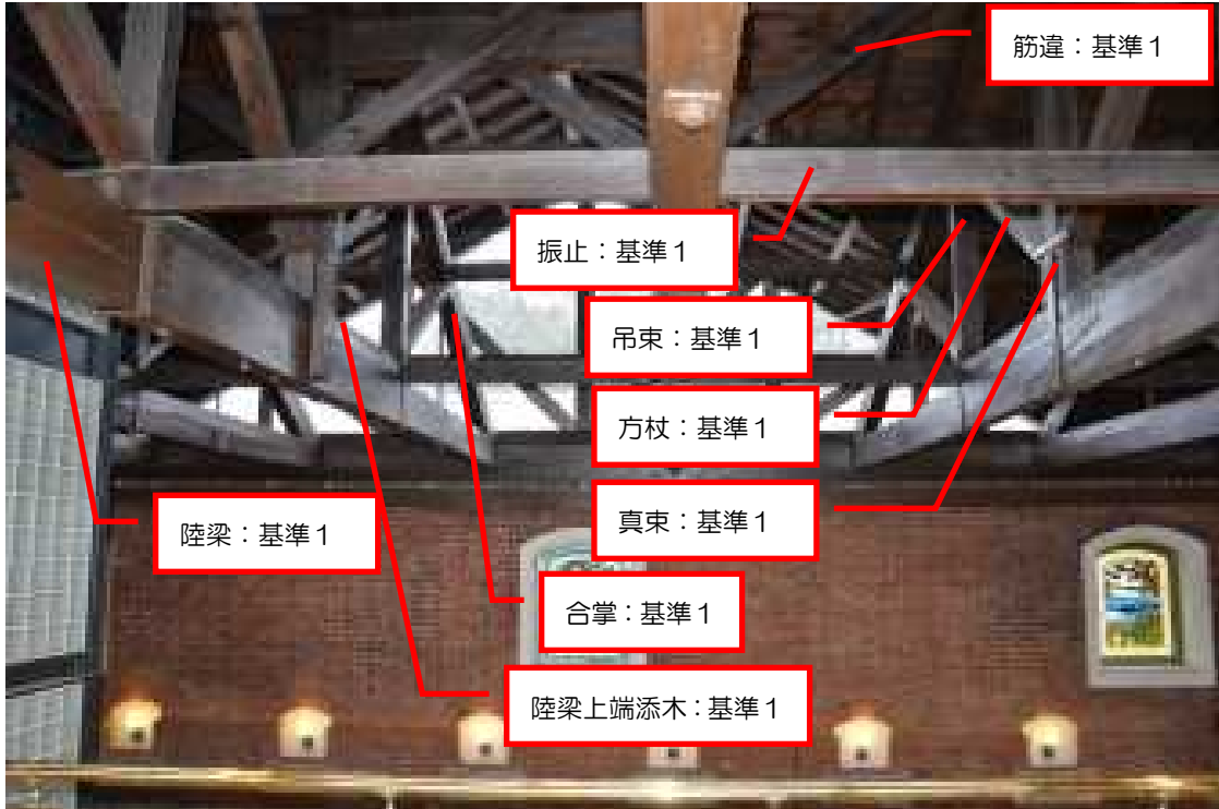
小屋組 西面を見る
