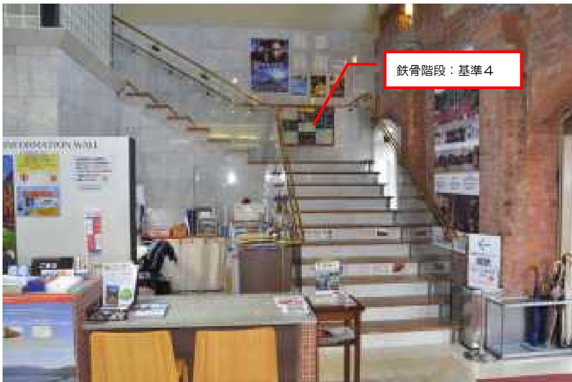
一階中央 鉄骨階段
