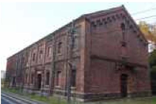
图 2.1.15 8号棟南西面 全景
