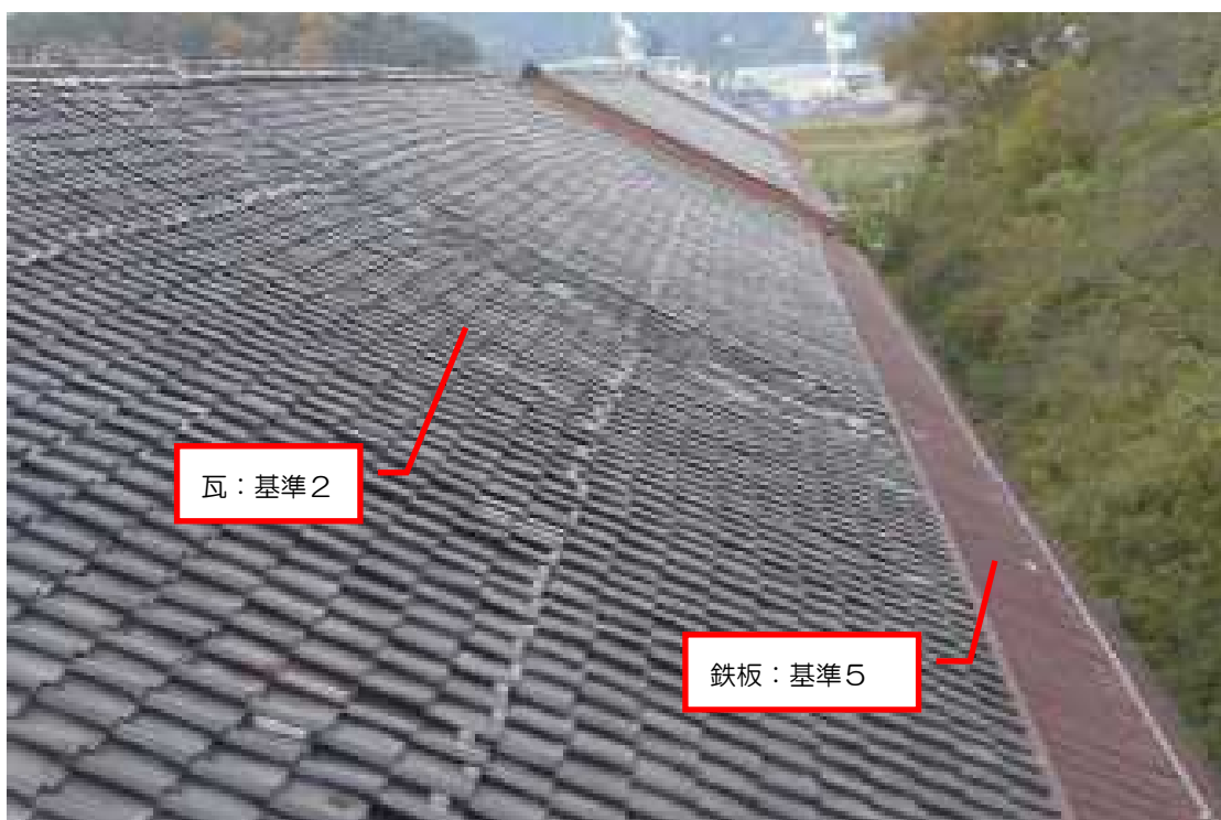
図2.2.42 6号棟、7号棟、8号棟 部分及び部位の保護方針10
