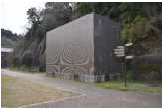
図 3.1.27 区域B 受変電設備
