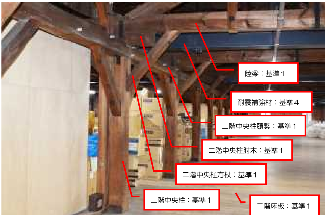
二階 中央柱廻り
