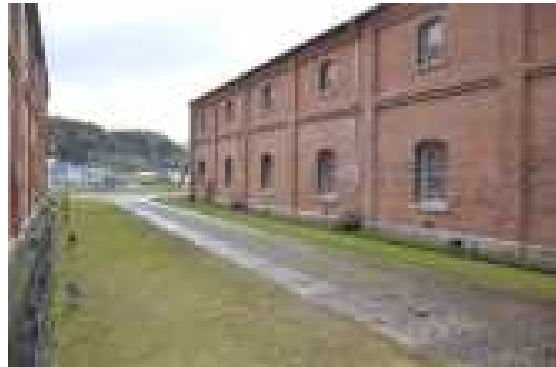
図 3.1.24 3号棟と4号棟の間 石敷通路
