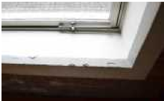
図 2.1.78 2号棟窓枠漆喰 破損状況
