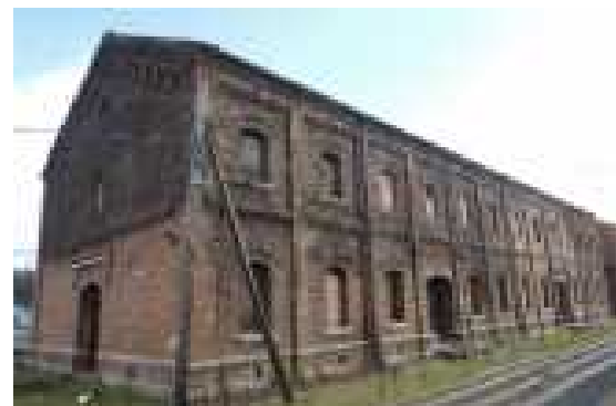
图 2.1.16 8号棟南西面 全景
