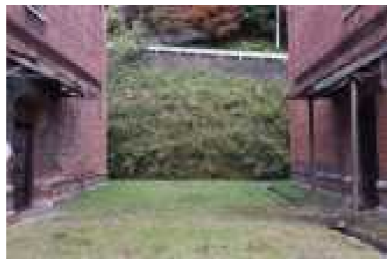
図 3.1.39 6号棟-7号棟間（軍港引込線ほか）
