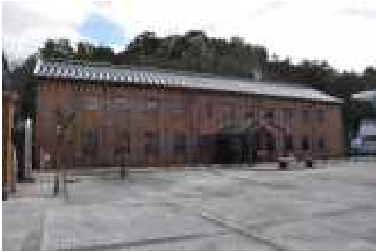
图 2.1.1 1号棟西面（正面） 全景
