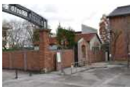
図 3.1.5 区域A北側RC塀・門
