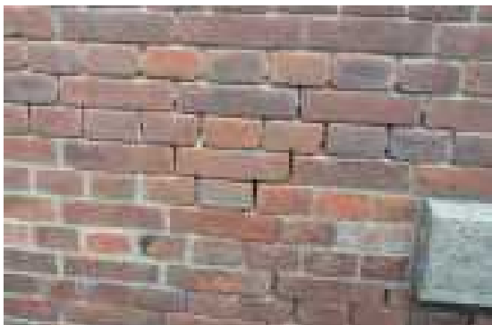
図 2.1.65 2号棟外壁煉瓦 目地空隙
