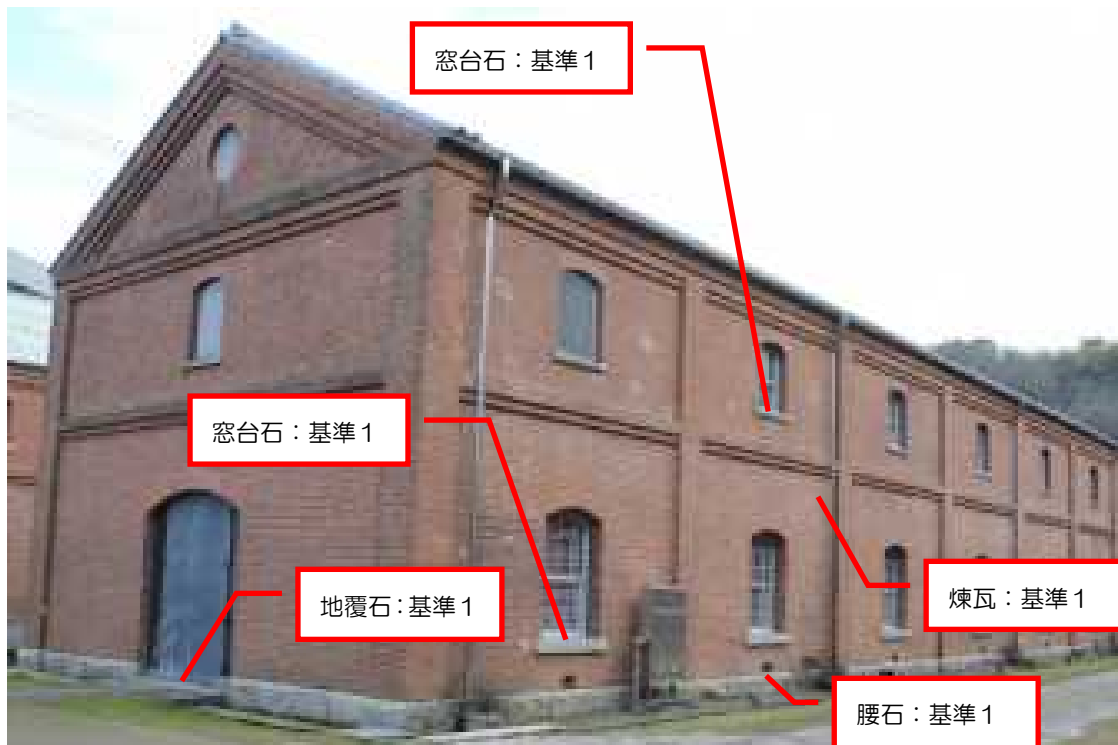
外壁 北面・東面
