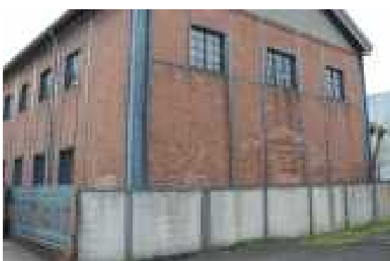
図 3.1.6 区域A北側RC塀 外側
