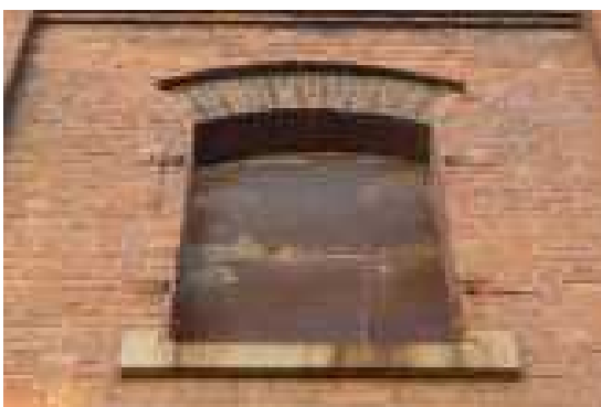
図 2.1.127 6号棟南面窓廻り 煉瓦破損状況
