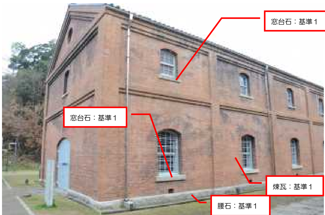
外壁 北面・東面
