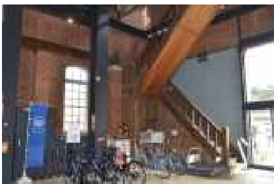
図 2.1.111 木造階段廻り
