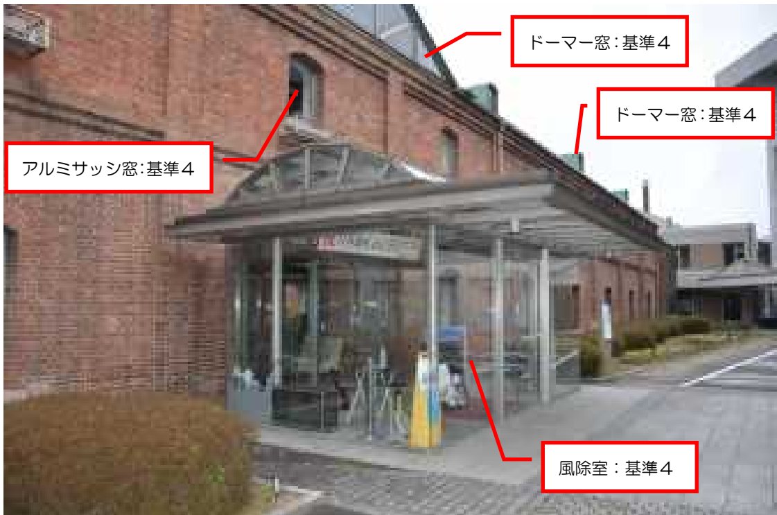
外観 正面（東面）
