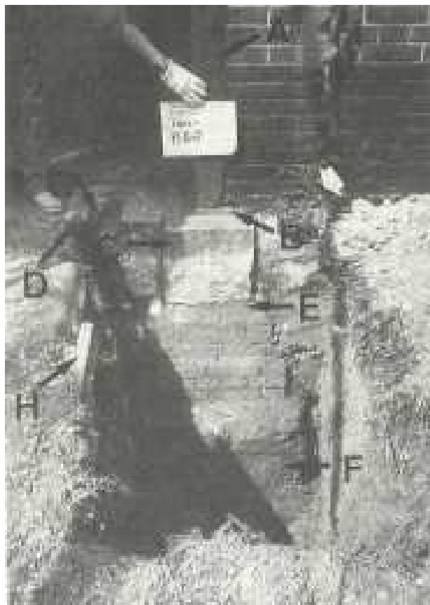
図2.1.17 基礎試掘状況（「調査報告書」より抜粋）
