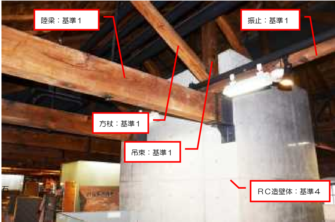
二階 RC造壁体廻り
