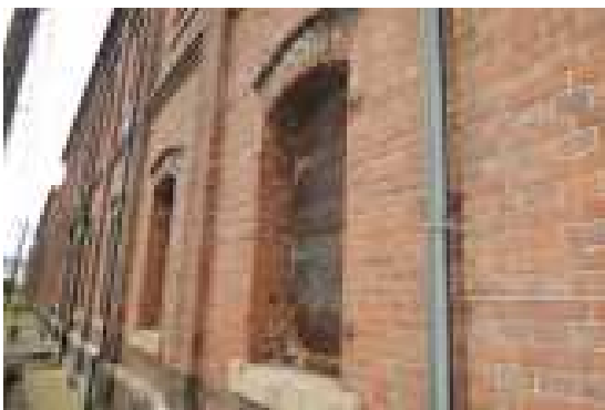
图 2.1.147 6号棟 南面一階窓
