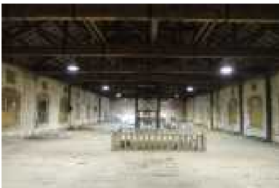
図 2. 1. 131 7号棟 二階 西を見る
