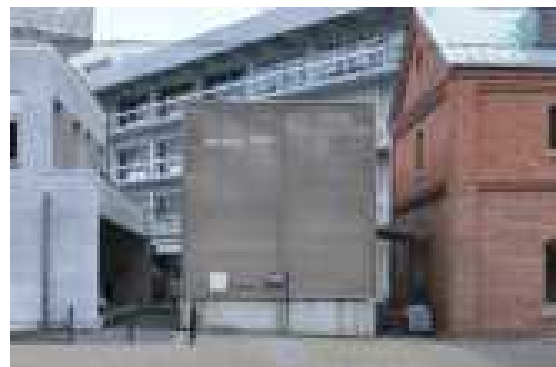
図 3.1.28 区域B 室外機置場
