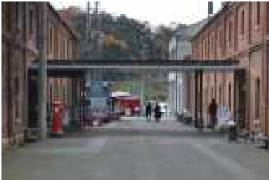
図 3.1.23 2号棟と3号棟の間
