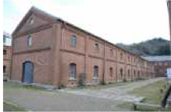
图 2.1.6 3号棟北西面 全景
