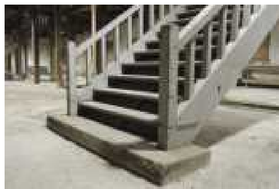
図 2.1.134 7号棟 階段一階部分
