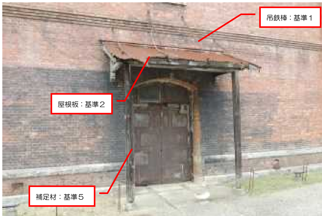
出入口 庇廻り
