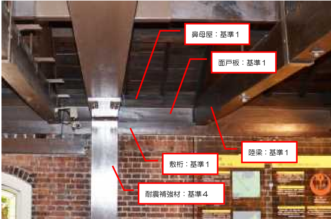
二階梁端部 西面を見る
