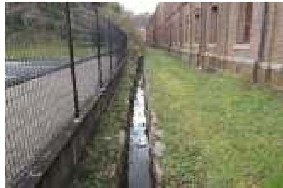
図 3.1.37 敷地内排水路（建物背面側）
