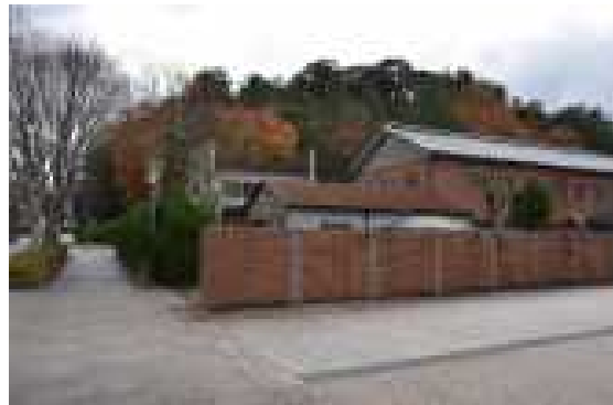
図 3.1.13 区域A外 近接建物
