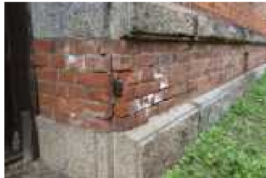
図 2.1.126 7号棟東面出入口 煉瓦破損状況
