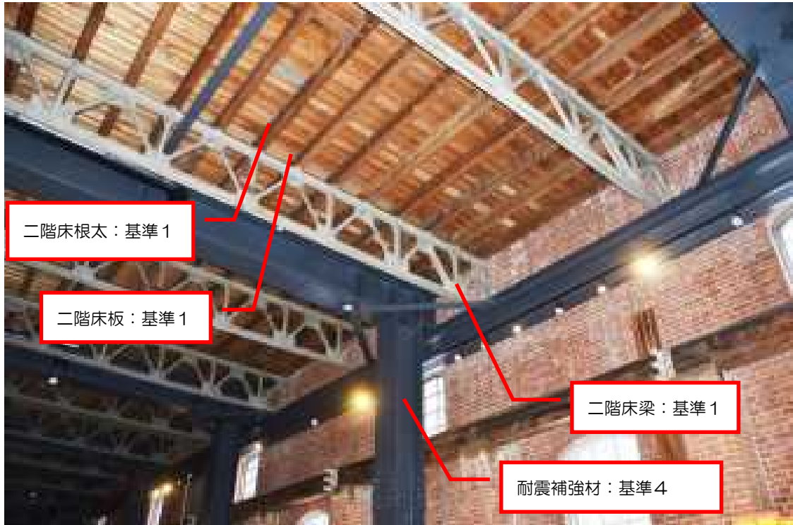
一階天井・二階床梁
