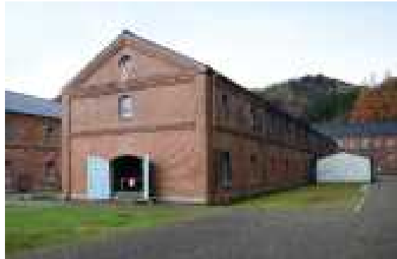
图 2.1.8 4号棟北西面 全景
