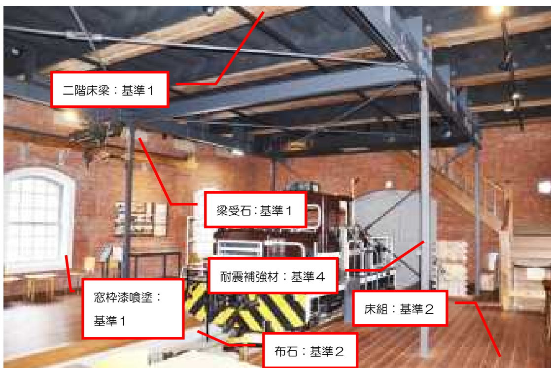
一階 南面を見る
