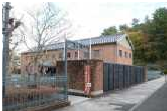
図 3.1.3 区域A南側RC塀・機械置場
