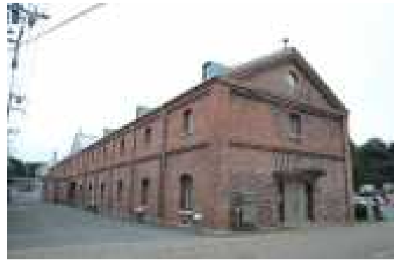
图 2.1.4 2号棟北西面 全景
