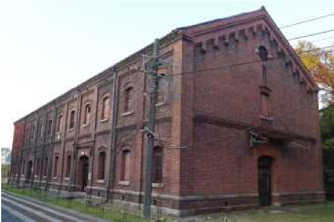
図 1.3.14 需品庫三棟のうち西側の棟（8号棟）（南から撮影）
