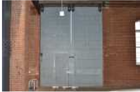
図 2.1.119 出入口吊り戸 内部から
