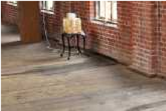
図 2.1.120 二階床雨染み
