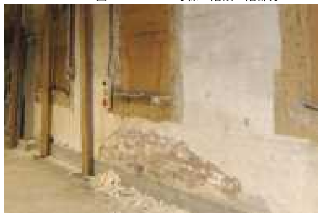
図 2.1.136 6号棟 一階漆喰剥落
