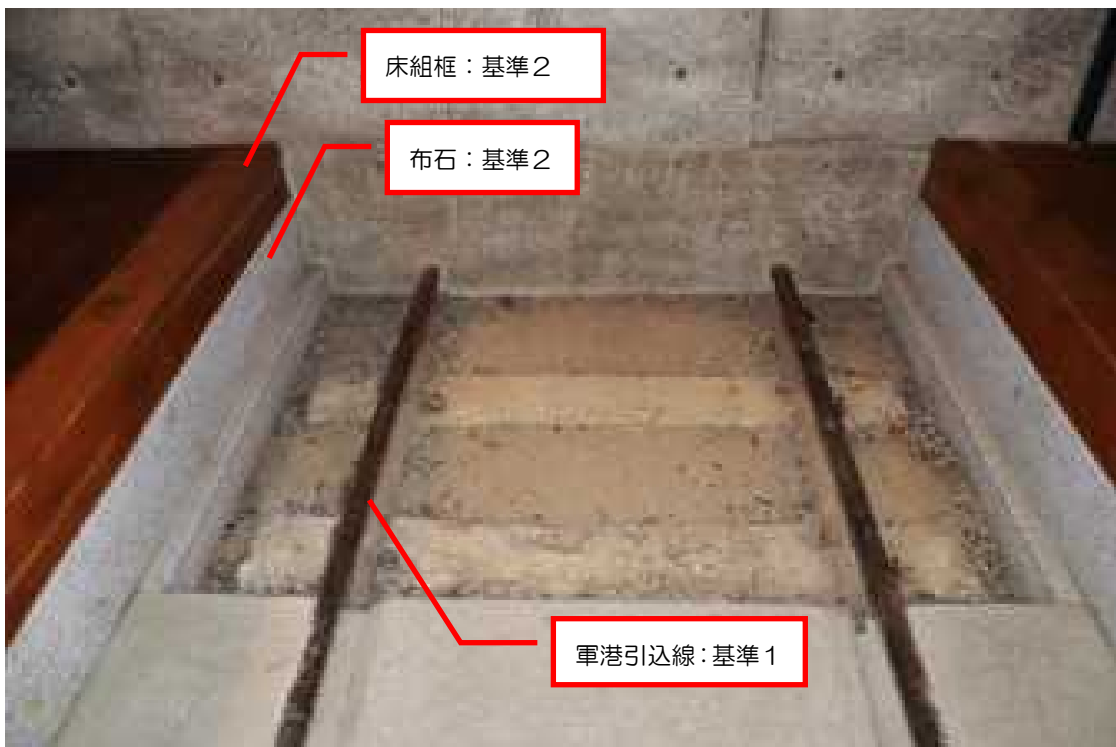
室内レール復旧部分
