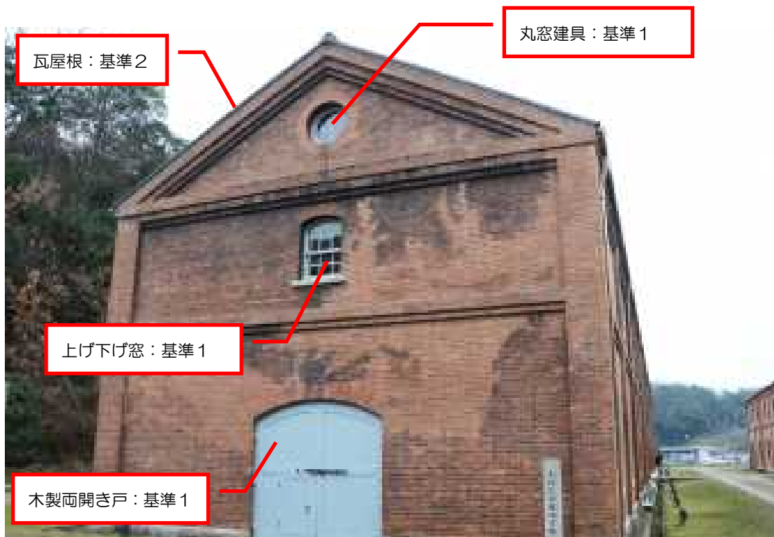
外観 南面・西面
