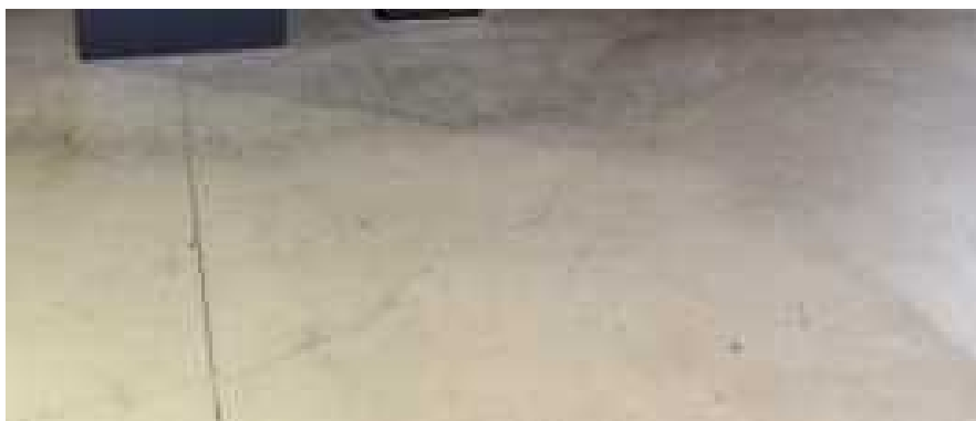
図 2.1.103 土間コンクリートひび割れ
