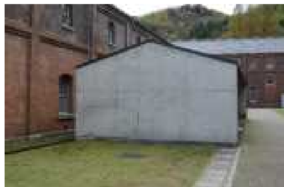
図 3.1.26 4号棟北側トイレ棟
