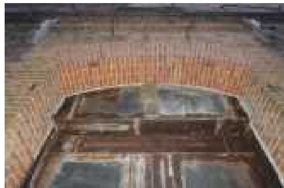
图 2.1.146 7号棟 西面出入口見上げ
