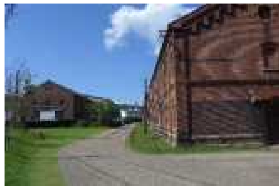
図 3.1.41 アスファルト舗装・電柱等
