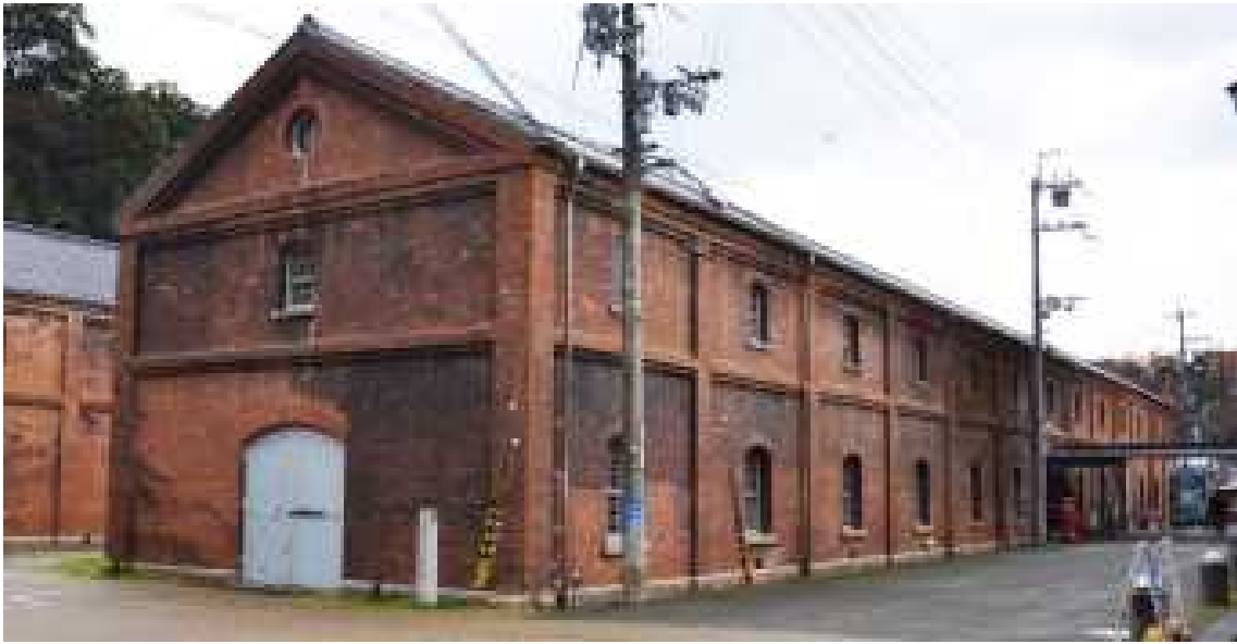
図 1.3.6 舞鶴海軍兵器廠弾丸庫並小銃庫（3号棟）（南東から撮影）
