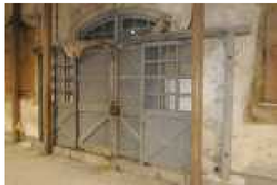
图 2.1.144 6号棟 南面東側出入口
