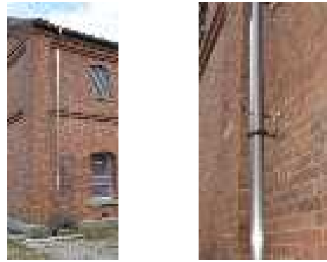
図 2.1.100 雨樋(左3号棟、右4号棟受金具)
