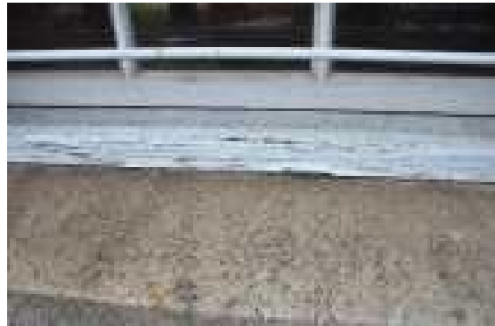
図 2.1.121 塗装の劣化
