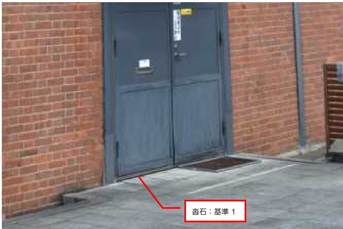
西面 出入口部分
