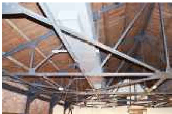
図 2.1.40 小屋組鉄骨トラス
