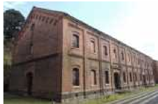
图 2.1.14 7号棟南西面 全景
