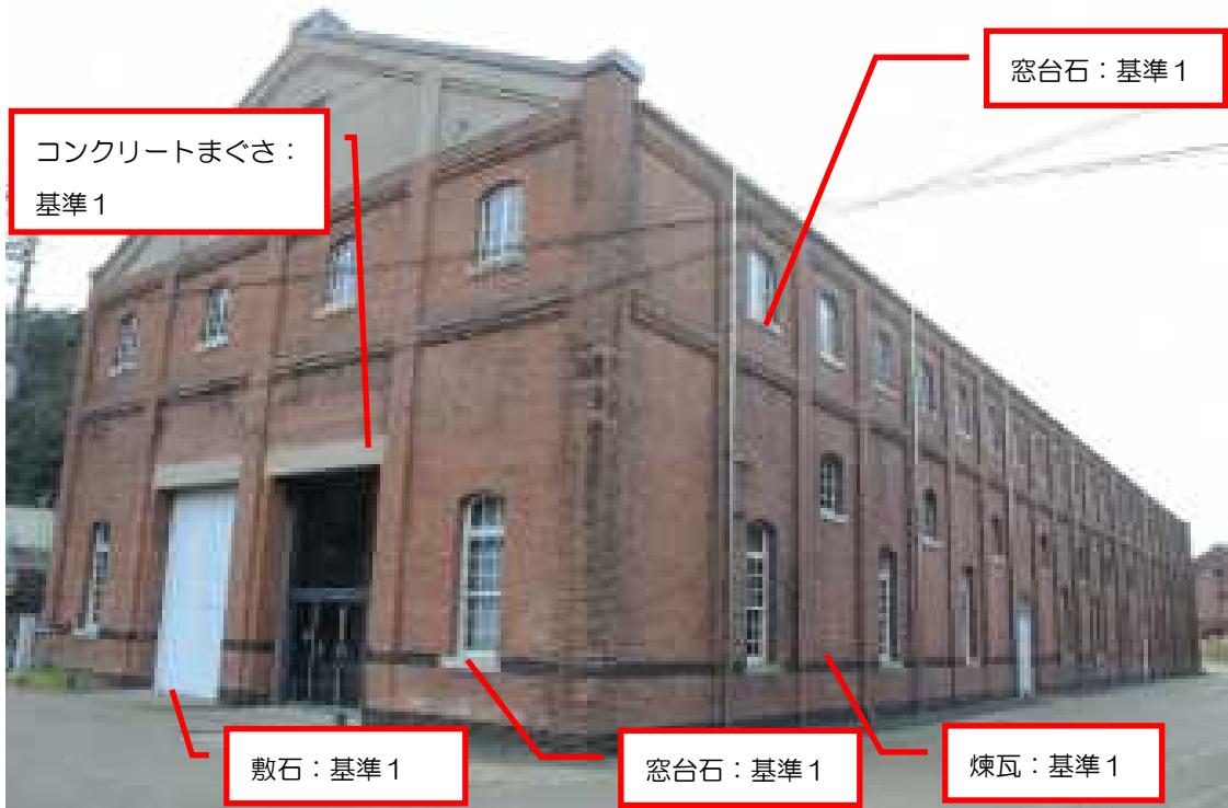
外観 北面・東面
