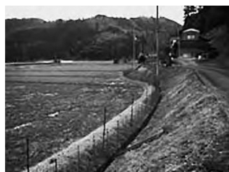
電気柵の設置状況
