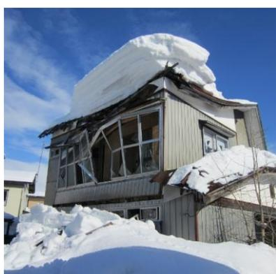
積雪により屋根や外壁が破損
