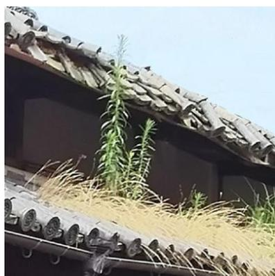
経年劣化により屋根瓦が崩落
