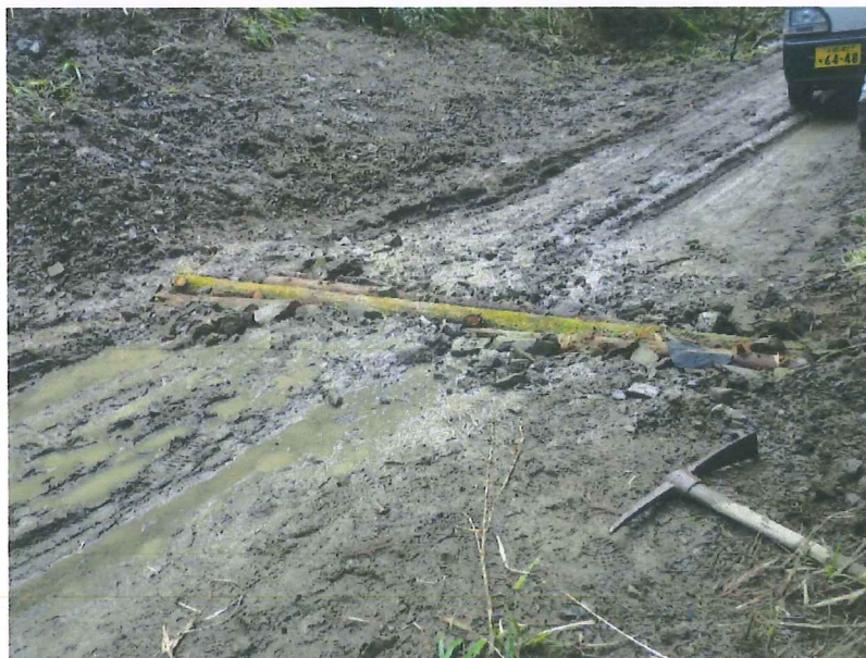
施工中 林道を掘り木材を埋設して水 切りを実施
