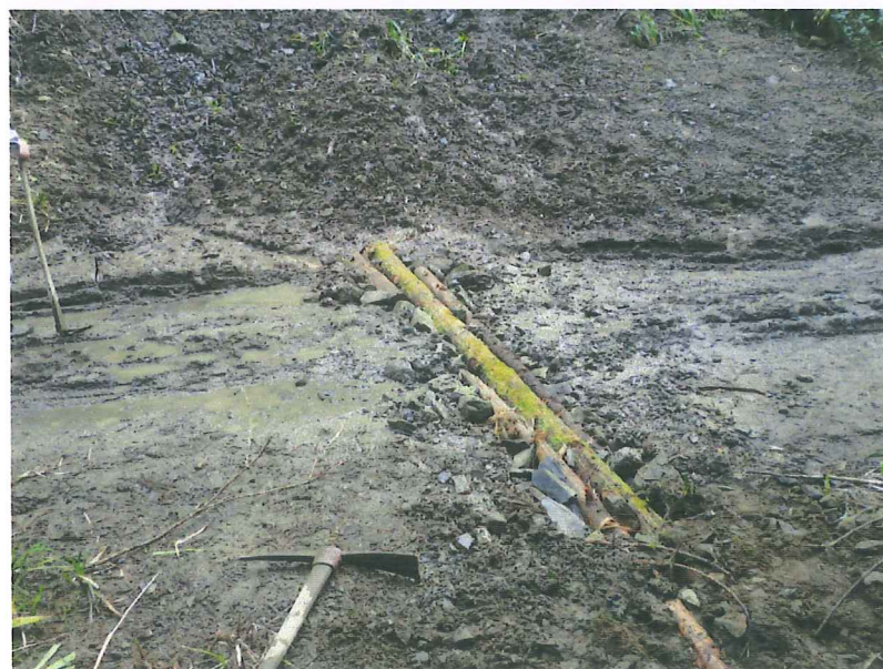
施工後 湧水が木材の間を違って川に 流れるように施工
