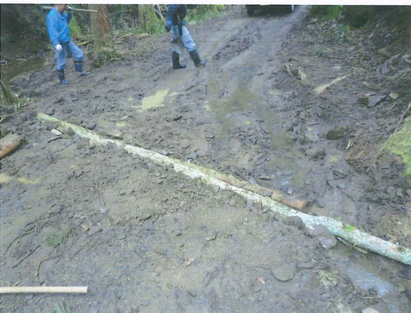
施工後 湧水が木材の間を流れて川に流れるように施工
