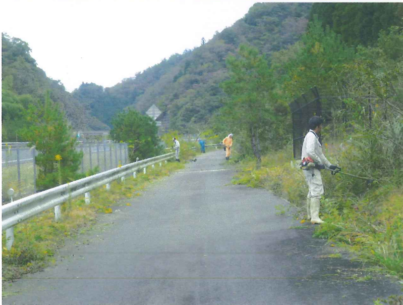
除草作業状況
