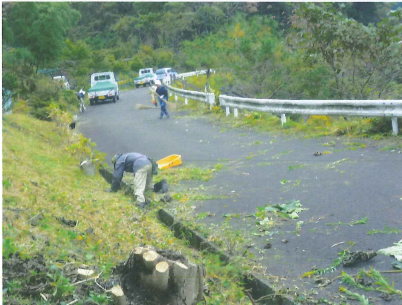
施工中 雑草を刈取り清掃している状況
