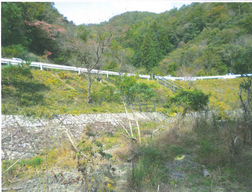
除草後の状況
