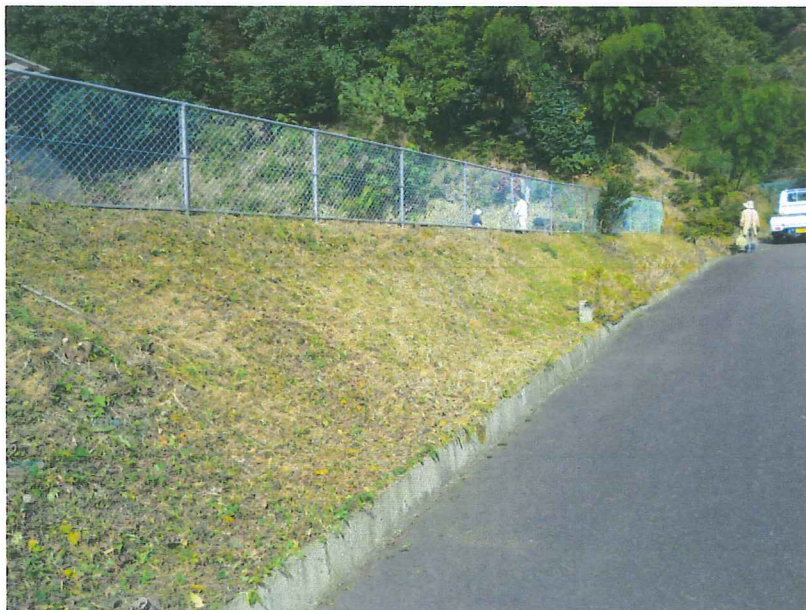
施工後 整備後の状況
