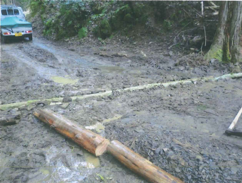
施工中 林道を掘り木材を埋設して水切りを実施
