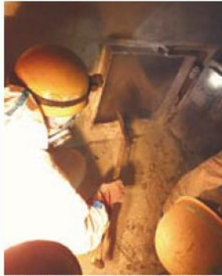
▲詰まった灰や金属を取り除く
