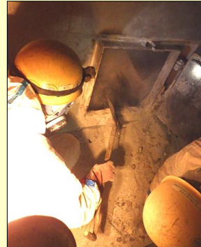
詰まり除去作業
