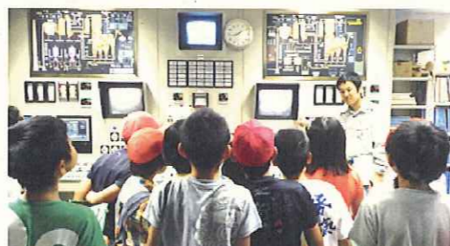
③ 中央制御室
