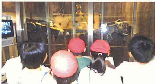
③ 中央制御室から見たごみクレーン
