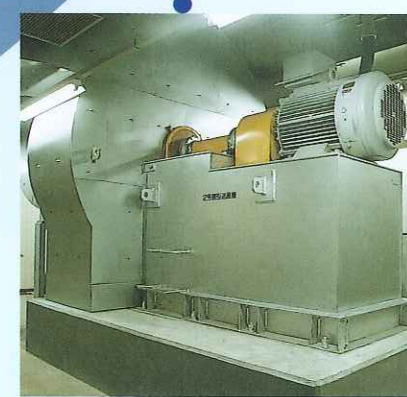
排ガスがろ過式集じん器を通過するために、強制的に吸引、排出するものです。
