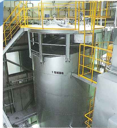
ガス減温器から出た排ガス温度をさらに、約170℃まで冷却します。
