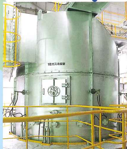
ガス冷却室は高温の排ガスを自動制御の水噴霧により、急速に冷却します。
