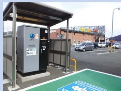
道の駅「舞鶴港とれとれセンター」の急速充電器 (平成28年2月設置)
