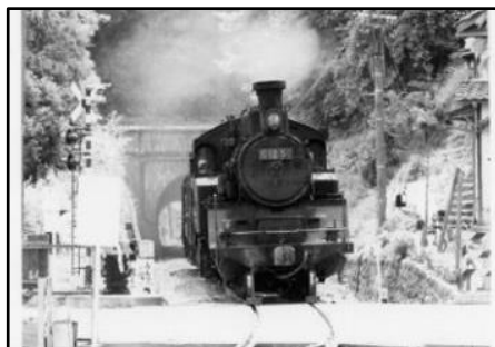
昭和46年頃の北吸トンネル
