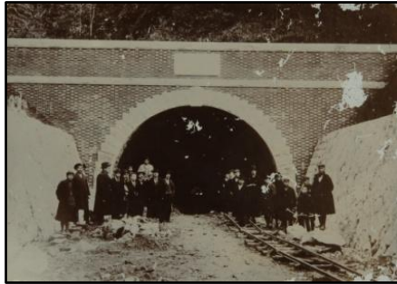
竣工時(明治34年)の道芝トンネル
