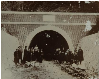
竣工時(明治34年)の道芝トンネル
