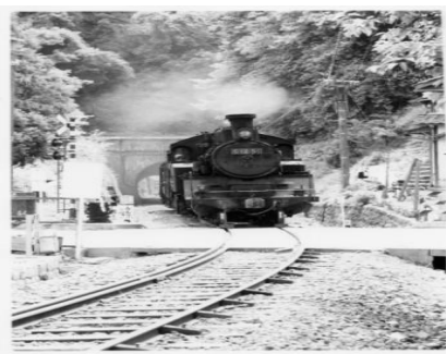
昭和46年頃の北吸トンネル
