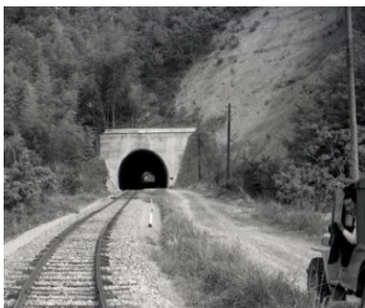
昭和35年頃の吉野トンネル
