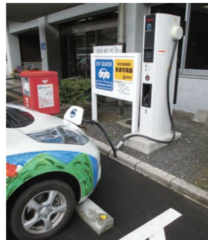
市役所玄関前に設置した急速充電器
