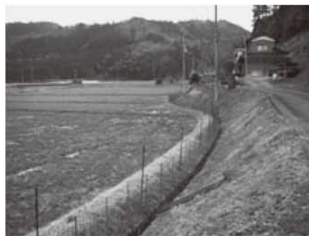
電気柵の設置状況
