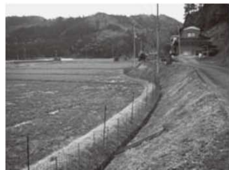
電気柵の設置状況
