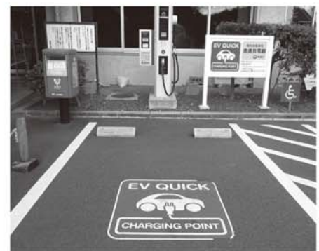
市役所本庁前の急速充電器
