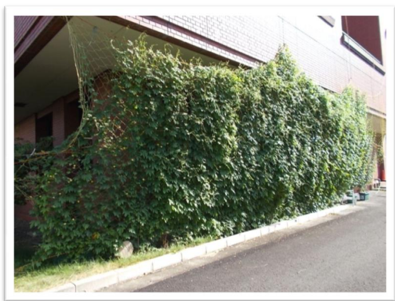
南面の窓全てを覆い尽くすみどりのカーテン
