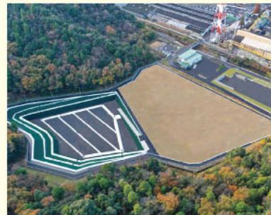
最終処分場の整備工事 費用: 約15億円 令和4年3月竣工
