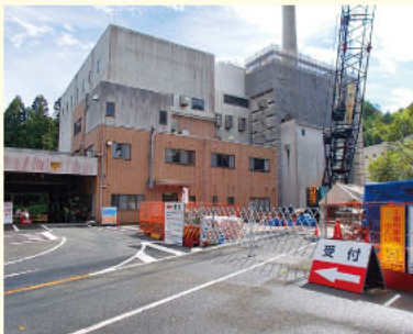
清掃事務所の長寿命化工事 費用: 約38億円 令和5年度完了予定
