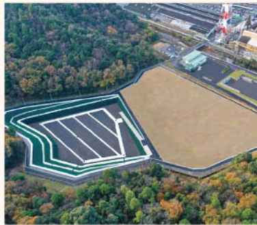
次期最終処分場の整備工事 費用：約15億円 令和4年3月竣工
