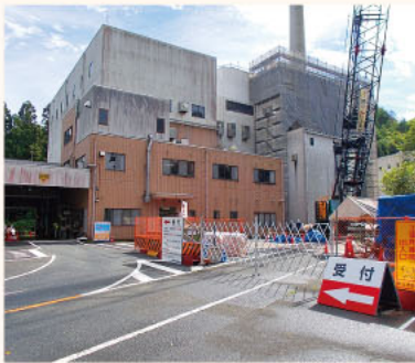
清掃事務所の長寿命化工事 費用：約38億円 令和5年度完了予定
