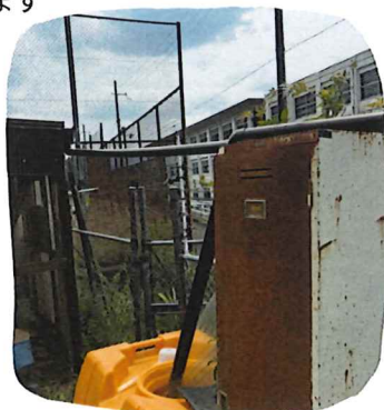
雨樋が完成しました！ 雨水の活用が可能に♪
