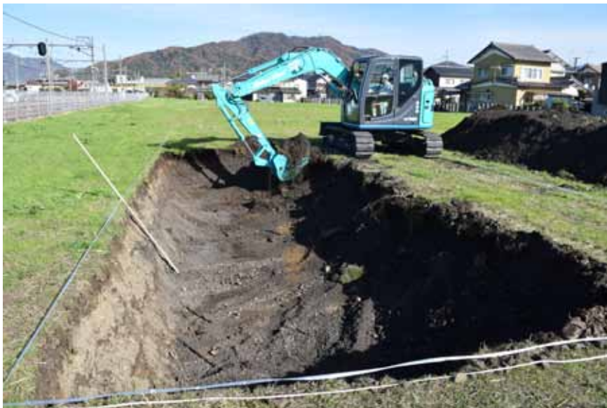
重機掘削状況 (南から)
