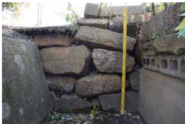
写真 2. 石垣露出地点（二ノ丸堀石垣）（北から）
