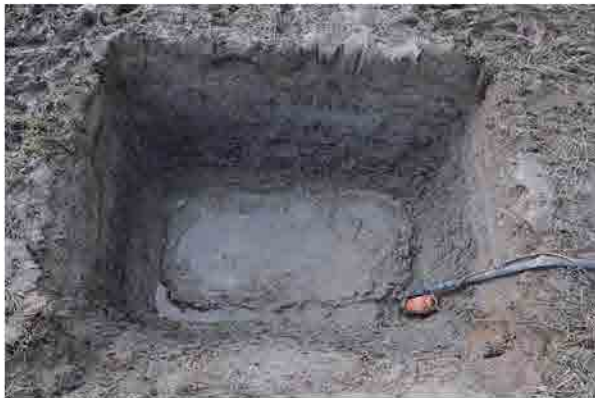
T2 完掘状況 (東から)
