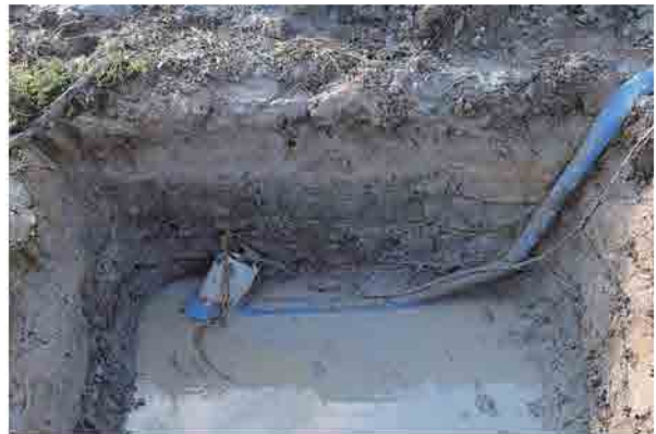
T4 西壁 (東から)
